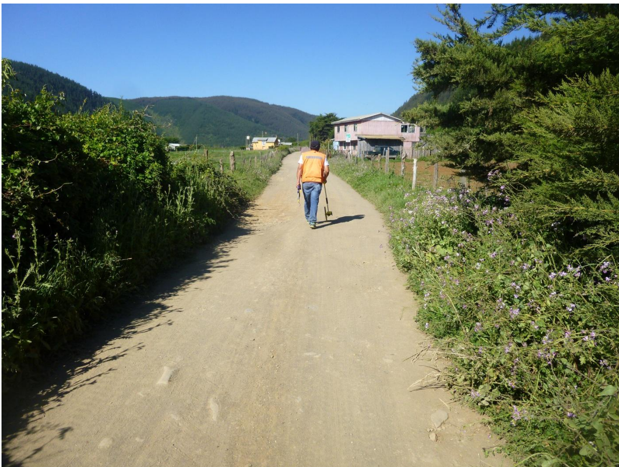
Km 0.240 vista adelante. Ancho de faja de 6.00 m; carpeta de 3.00 m +0.80 m de cuneta i/d. punto alto. Carpeta sin presencia de material granular en buen estado. La rasante del camino se encuentra a una misma cota lados i/d, agua lluvia escurre asía punto bajo anterior. Postes eléctricos en faja
