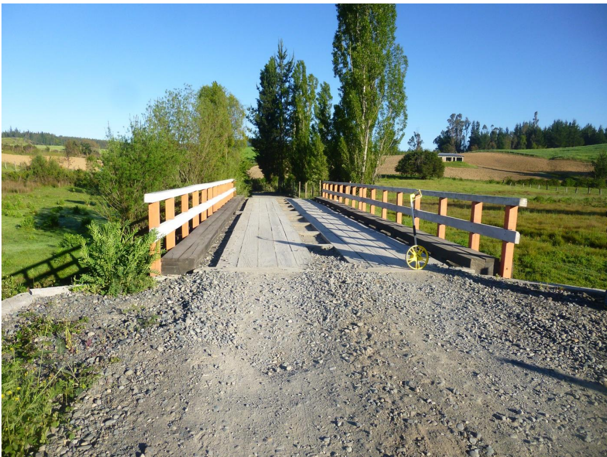
Km 0.430 vista adelante. Ancho de faja 8.50 m. carpeta de 4.00 m. al hombro de la carpeta, cuneta lado i/d + 0.50 m. Carpeta con buena presencia de material granular en buen estado. Agua escurre apunto bajo del km. anterior. Acceso al puente El Manzano.
