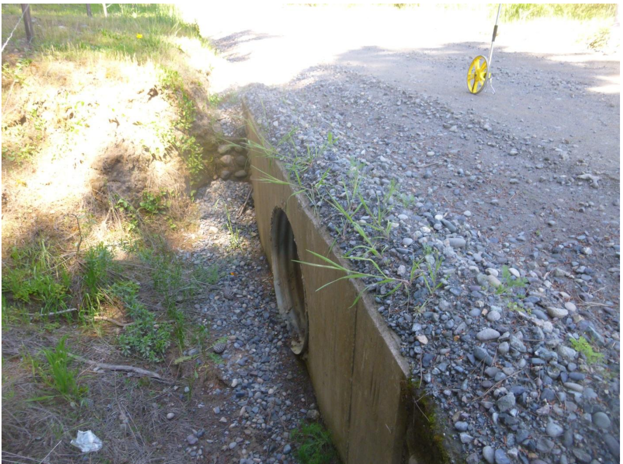
Km 4.10 vista adelante. Ancho de faja 11.00 m. carpeta de 4.50 m. al hombro de la carpeta, cuneta lado i/d + 0.70m. En este punto se encuentra la rasante a un nivel inferior con respecto a terrenos aledaños lado izq. superior lado der. Carpeta en buen estado. Alcantarilla A.C diámetro 1000 mm. Largo 7.00 mts. Zonas de curvas.
