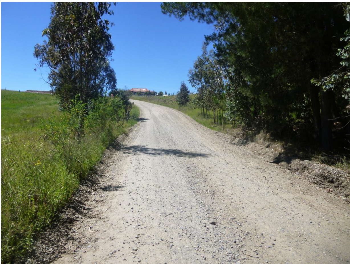
km 1.00 vista adelante. Ancho de faja 9.00 m. carpeta de 4.00 m. al hombro de la carpeta, cuneta lado i/d + 0.70 m. Carpeta con buena presencia de material granular en buen estado. La rasante del camino se encuentra a una misma cota inferior lados d/i.
