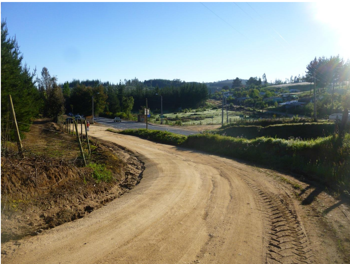
Km 0.280 vista adelante. Ancho de faja 8,50 m, carpeta de 5.00 m al hombro + 0.75 m de cuneta i/d. se aprecia intersección con ruta Trehuaco – Quirihue donde ruta atraviesa para el lado oriente de la ruta N-126. Agua lluvia evacua a hacia ruta N-126
