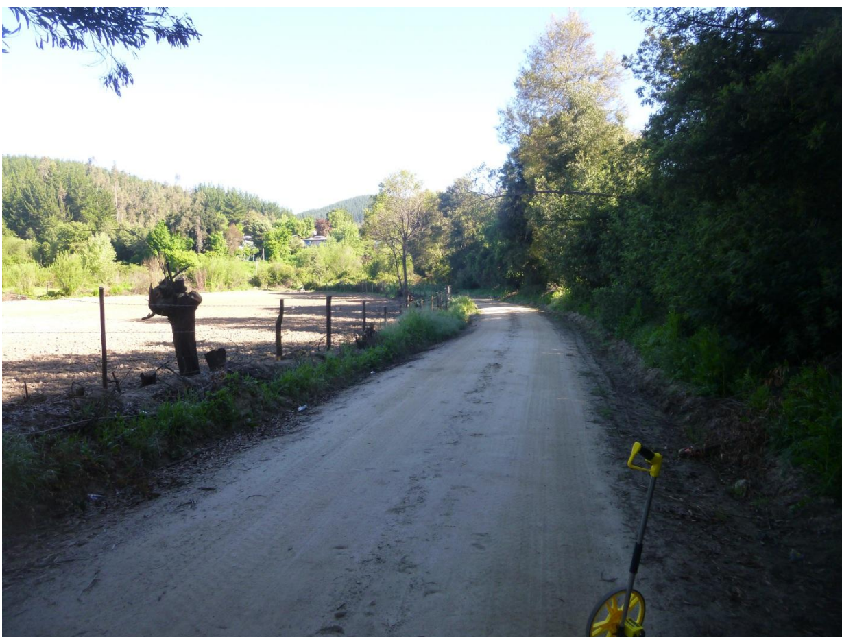
Km 3.00 vista adelante. Ancho de faja 11.00 m. carpeta de 3.50 m. al hombro de la carpeta, cuneta lado izq + 0.4 m. y lado der + 0.8 m. Carpeta con poca presencia de material granular en buen estado la rasante del camino con respecto al nivel de los
