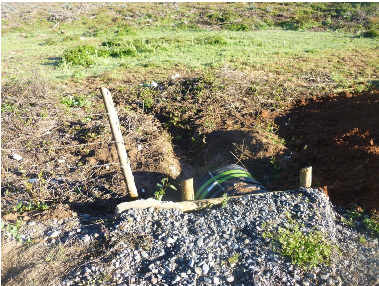
Km 0.752 vista adelante. Ancho de faja 9.50 m. carpeta de 3.50 m. al hombro de la carpeta, cuneta lado izq + 0.8 m. y lado der + 0.6 m. la rasante del camino con respecto al nivel de los terreno aledaños está a una misma cota que terrenos aledaños. Se aprecia una alcantarilla de HPDE de diámetro de 800 mm. Largo 9.50 mts. Postes eléctricos en faja.
