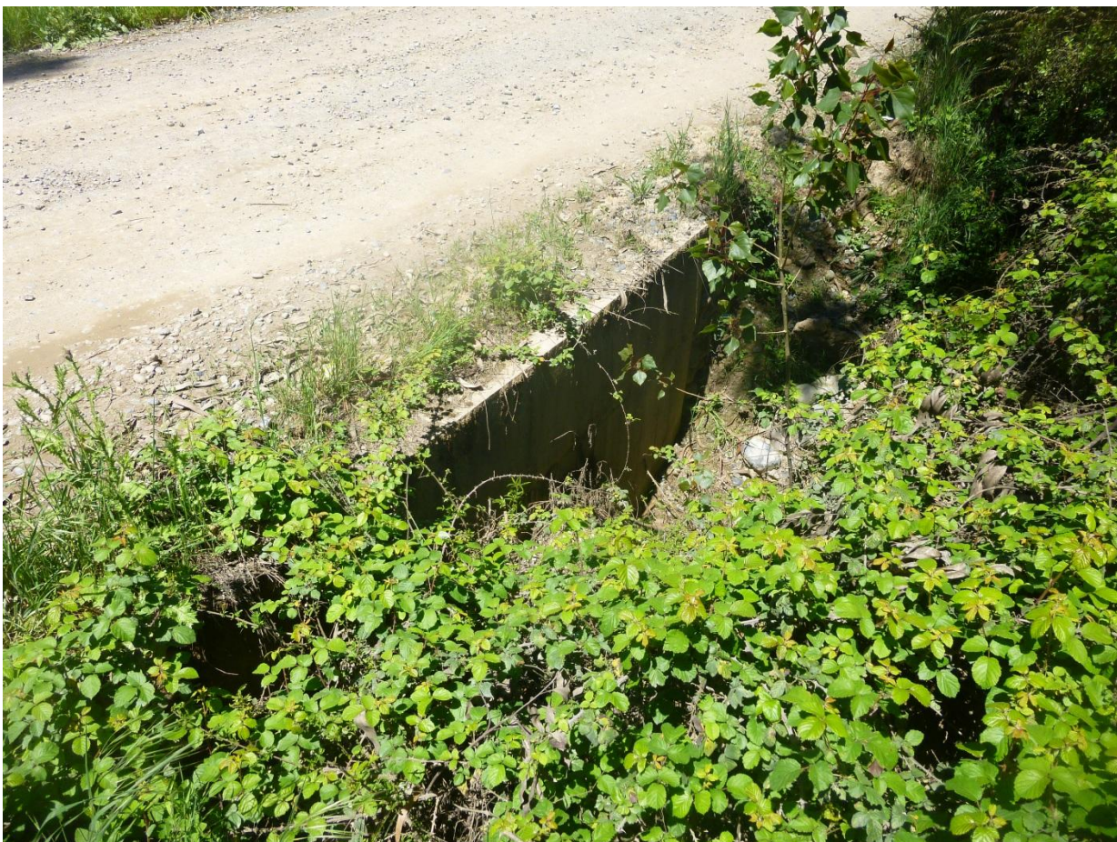
Km 3.30 vista adelante. Ancho de faja 8.50 m. carpeta de 4.50 m. al hombro de la carpeta, cuneta lado i/d + 0.70m. En este punto se encuentra la rasante a un mismo nivel lado i/d. Postes eléctricos en faja del camino. Carpeta en buen estado, zona poblada. Alcantarilla de A.C de diámetro 800 mm. Largo de 9.00 mts.
