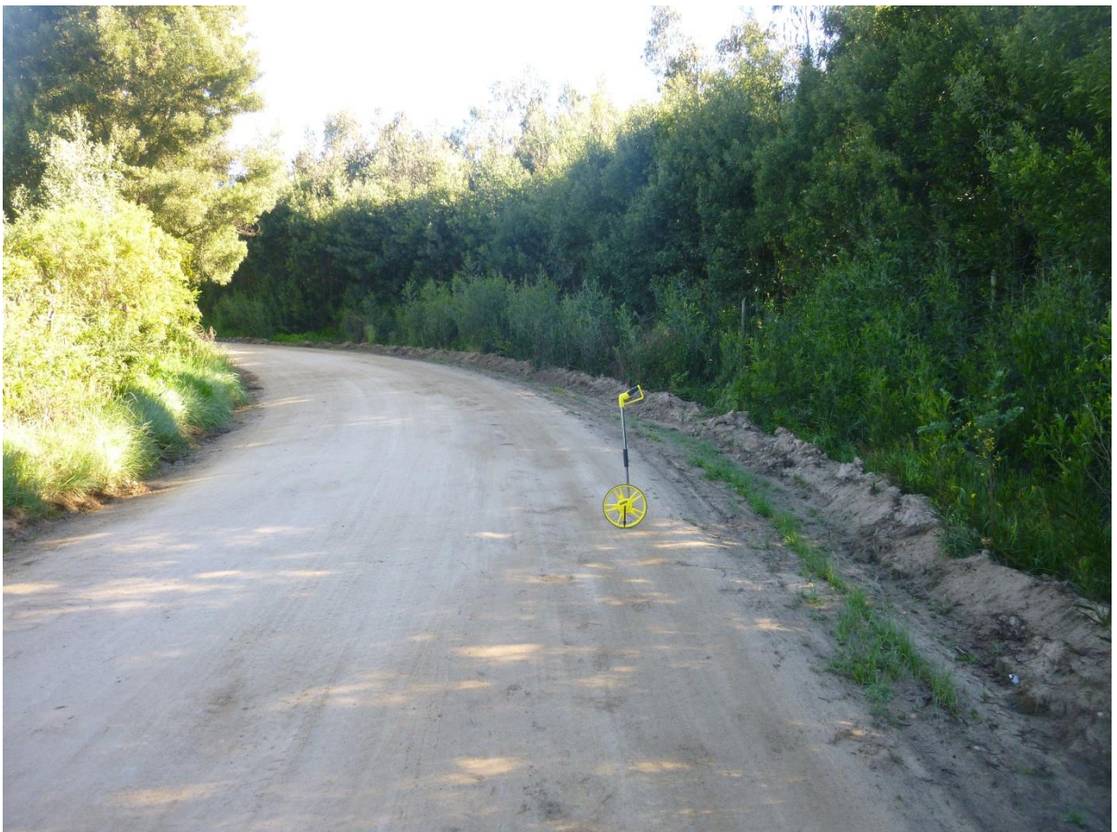
Km 2.80 vista adelante. Ancho de faja 11.00 m. carpeta de 4.50 m. al hombro de la carpeta, cuneta lado izq + 0.4 m. y lado der + 0.8 m. Carpeta con poca presencia de material granular en buen estado la rasante del camino con respecto al nivel de los terreno aledaños está a una cota inferior i/d. Zonas de curvas
