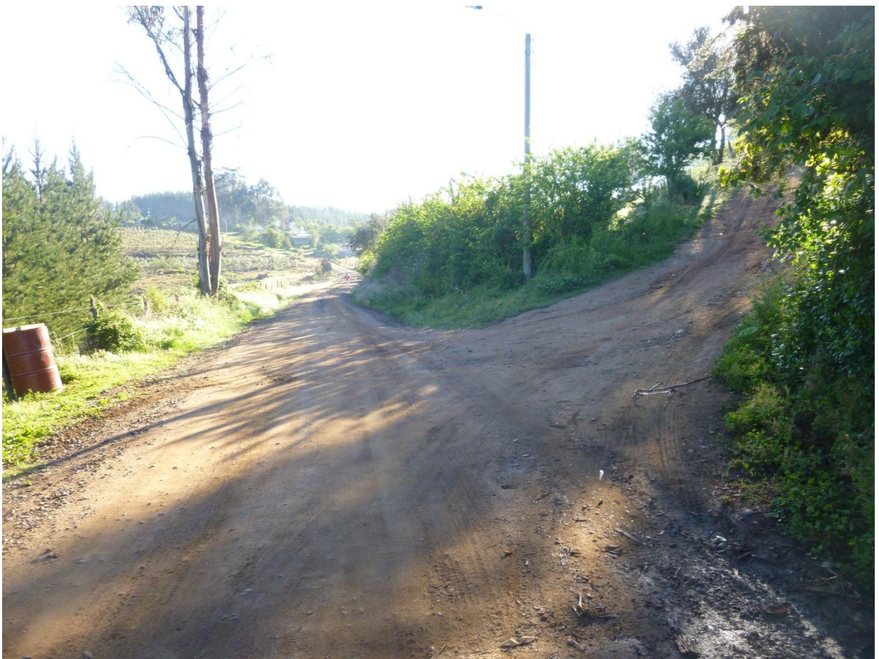
Km 0.600 vista adelante. Ancho de faja 8.50 m, carpeta de 3.00 m + 1.00 m de cuneta i/d. En este punto se encuentra la rasante a un nivel superior con respecto al promedio en general del camino lado izq. e inferior lado der. Agua escurre a punto bajo más adelante. Se aprecia camino lateral acceso a predio particular.
