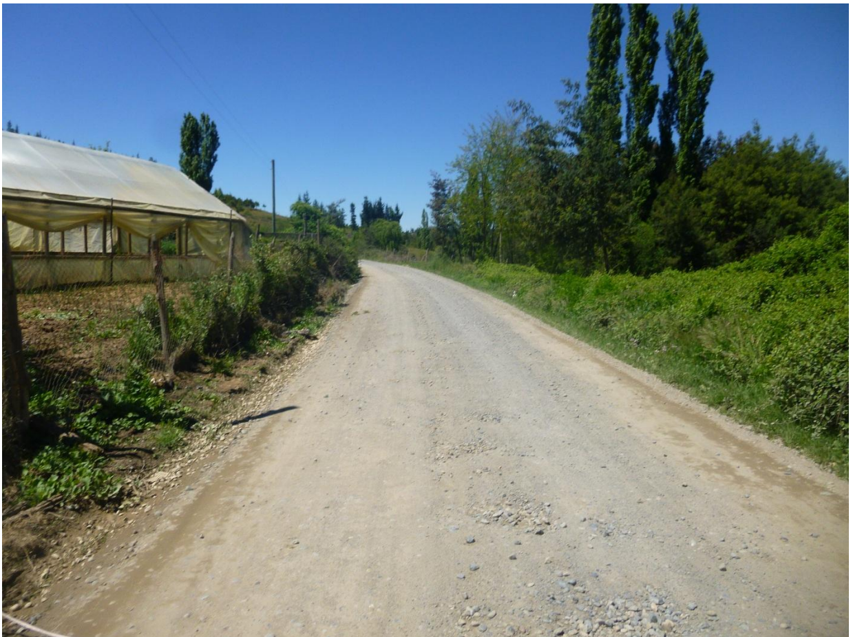
Km 2.20 vista adelante. Ancho de faja 8.00 m. carpeta de 4.50 m. al hombro de la carpeta, cuneta lado i/d + 0.70m. En este punto se encuentra la rasante del camino a un nivel inferior con respecto a los terrenos aledaños lado izq. y superior lado der. Zona poblada.
