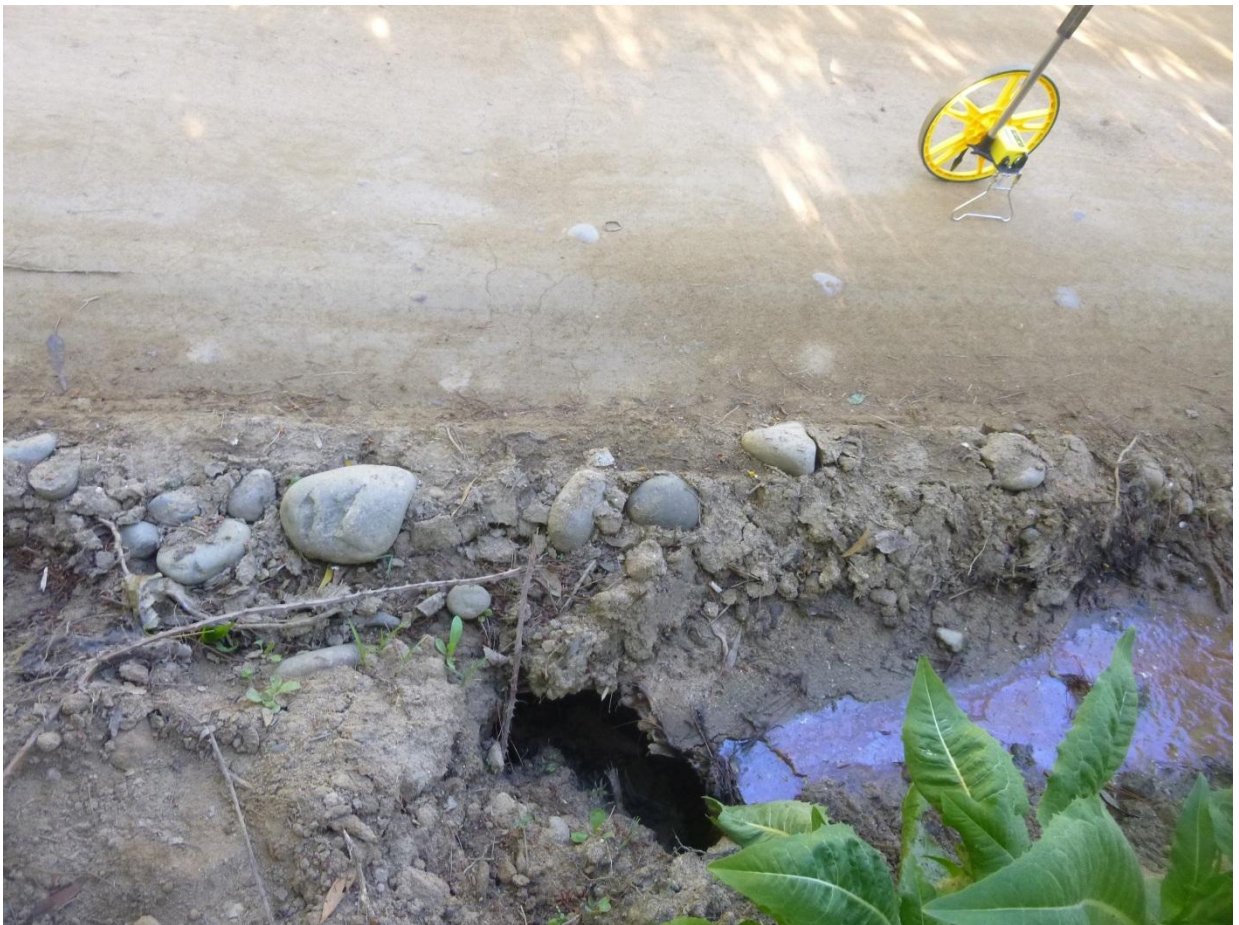
Km 1.574 vista adelante. Ancho de faja 10.00 m. carpeta de 4.00 m. al hombro de la carpeta, cuneta lado izq + 0.6 m. y lado der + 0.8 m. la rasante del camino con respecto al nivel de los terreno aledaños está a una misma cota lado der. Y superior lado izq. existe alcantarilla HPDE de diámetro de 600 mm. Largo 6.00 mts. Zonas de curvas
