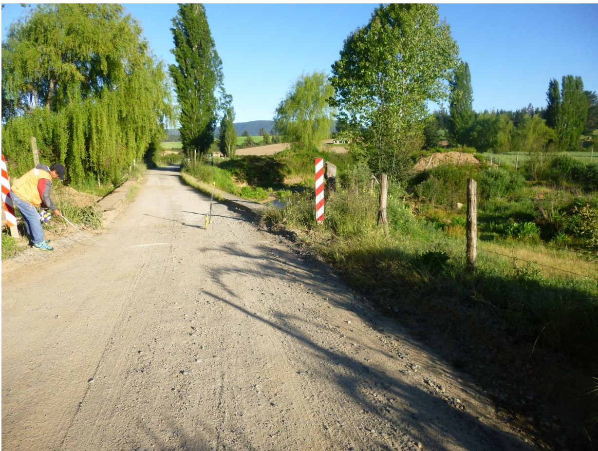
Km 0.100 vista adelante. Ancho de faja de 10.00 m; carpeta de 5.50 m +0.70 m de cuneta i/d. Carpeta con buena presencia de material granular en buen estado. La rasante del camino se encuentra a una cota superior lados izq. e inferior lado der
