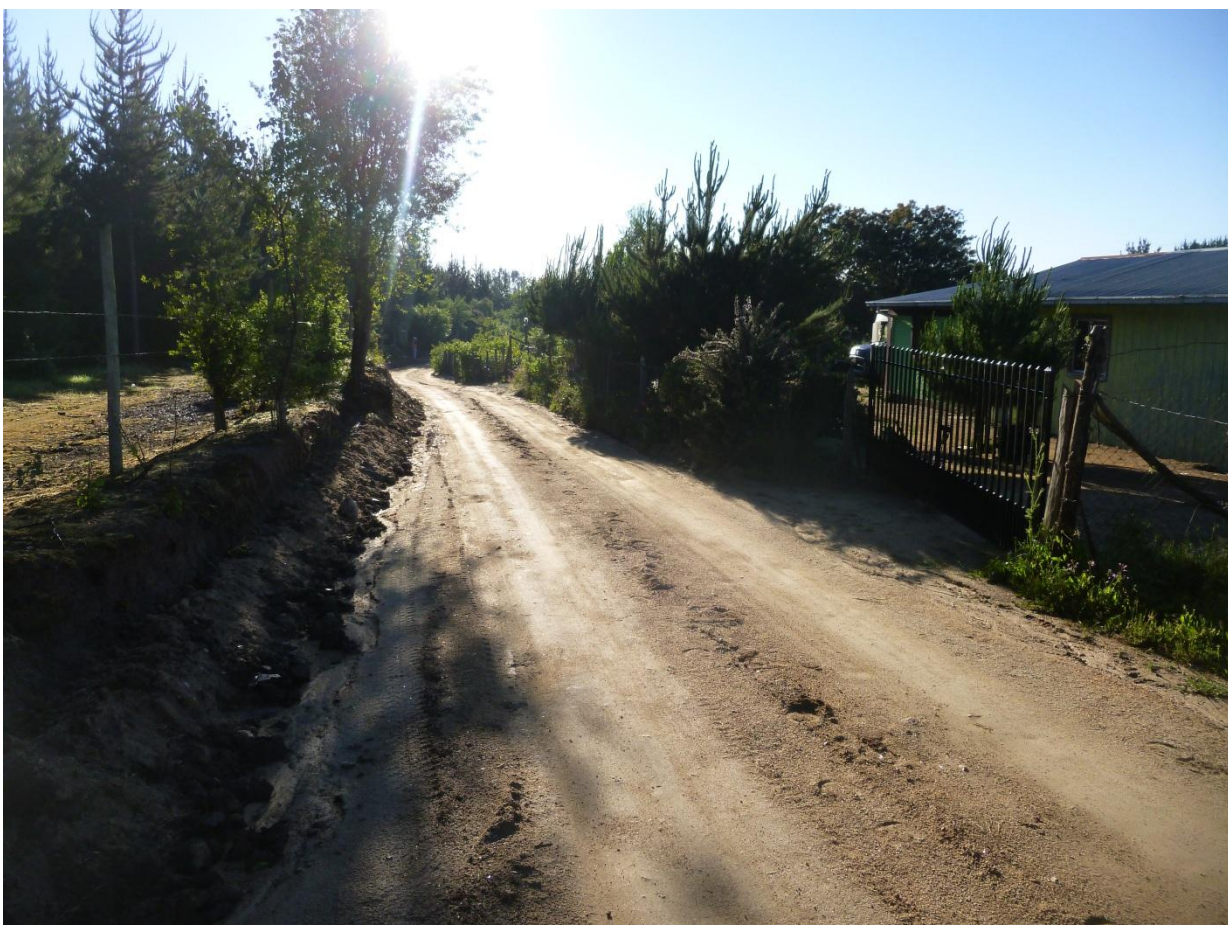
Km 0.100 vista adelante. Ancho de faja de 6.50 m; carpeta de 3.00 m +0.90 m de cuneta i/d. punto alto. Carpeta sin presencia de material granular en buen estado. La rasante del camino se encuentra a una cota inferior lados izq. y misma cota lado der, agua lluvia escurre asía punto bajo más adelante.
