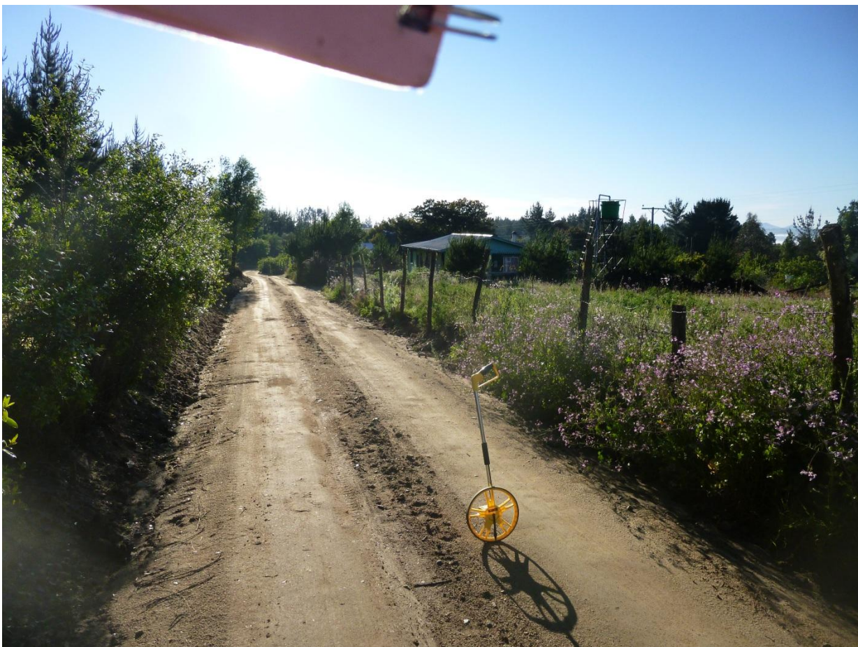
Km 0.00 vista adelante. Ancho de faja de 6.50 m; carpeta de 3.00 m +0.60 m de cuneta i/d. punto alto. Carpeta sin presencia de material granular en buen estado. La rasante del camino se encuentra a una cota inferior lados i/D, agua lluvia escurre asía punto bajo más adelante.
