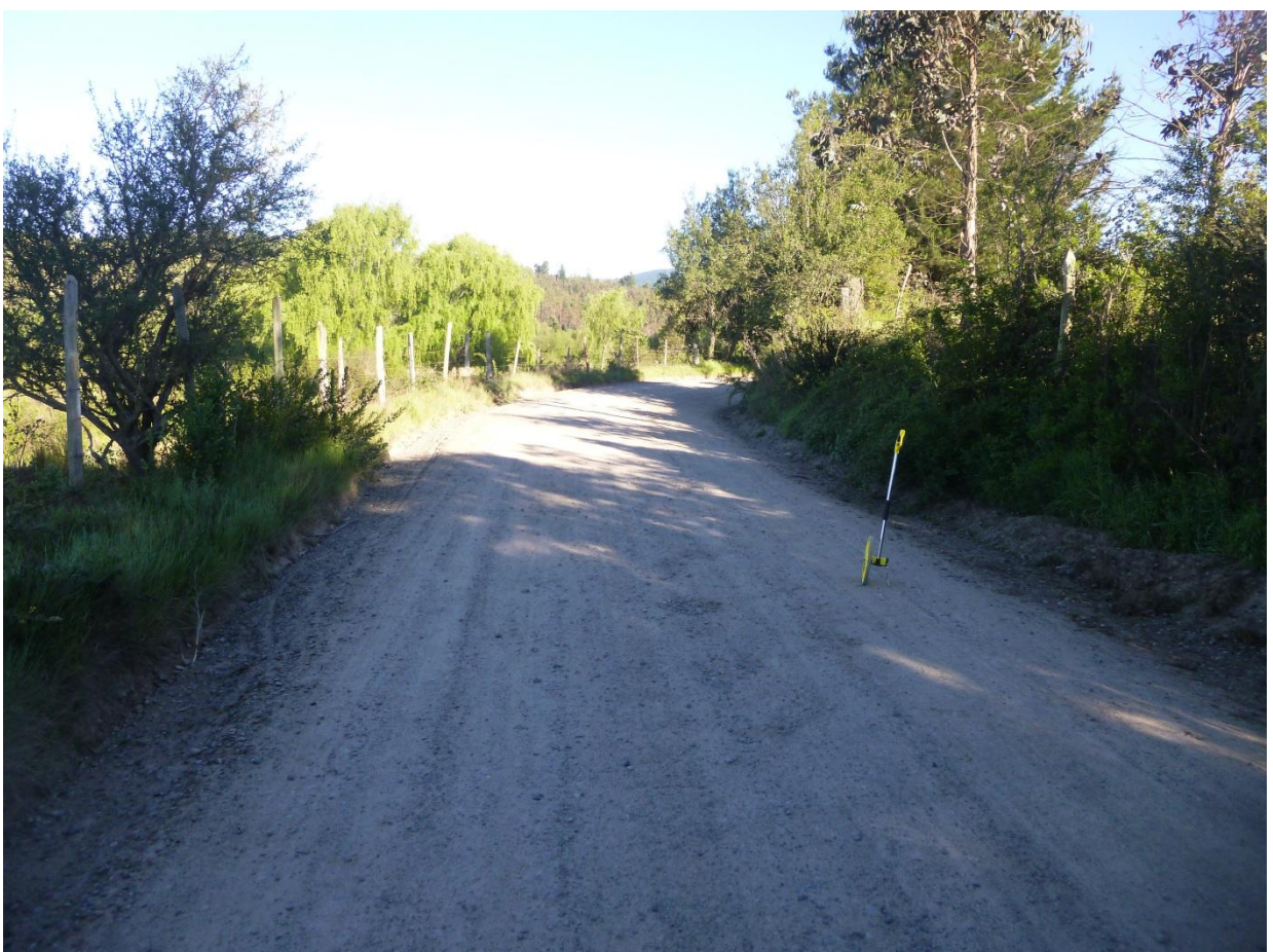
km 0.980 vista adelante. Ancho de faja 9.00 m. carpeta de 4.50 m. al hombro de la carpeta, cuneta lado i/d + 0.40 m. Carpeta con buena presencia de material granular en buen estado. La rasante del camino se encuentra a una cota inferior lados der. y superior
