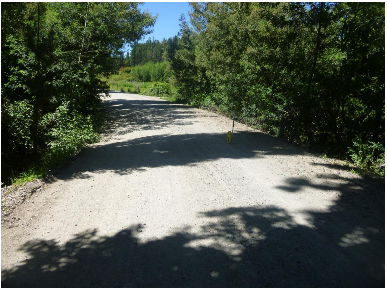
Km 0.600 Km 0.400 vista adelante. Ancho de faja 10.00 m. carpeta de 4.50 m. al hombro de la carpeta, cuneta lado i/d + 0.70 m. Carpeta con buena presencia de material granular en buen estado. Rasante al mismo nivel que terrenos aledaños. Lados i/d.
