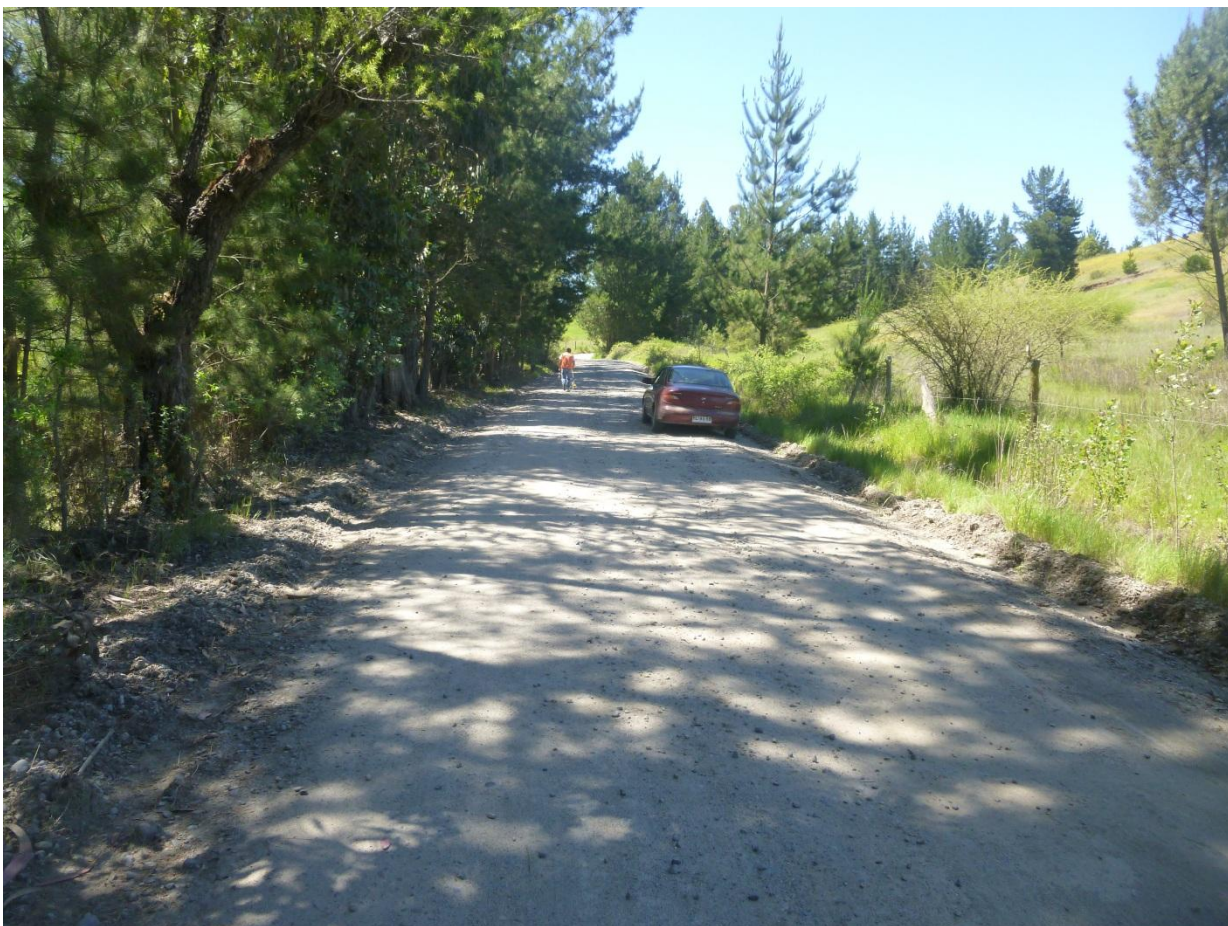
Km 0.800 vista adelante. Ancho de faja 10.00 m. carpeta de 4.50 m. al hombro de la carpeta, cuneta lado i/d + 0.70 m. Carpeta con buena presencia de material granular en buen estado. Rasante al mismo nivel que terrenos aledaños. Lados i/d.
