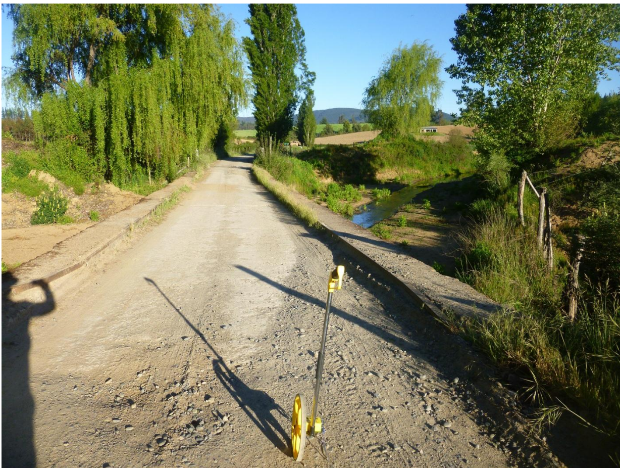
Km 0.300 vista adelante. Ancho de faja de 6.00 m; carpeta de 3.00 m +0.50 m de cuneta i/d. Carpeta con buena presencia de material granular en buen estado. La rasante del camino se encuentra a una cota superior i/d. se aprecia puente de hormigon
