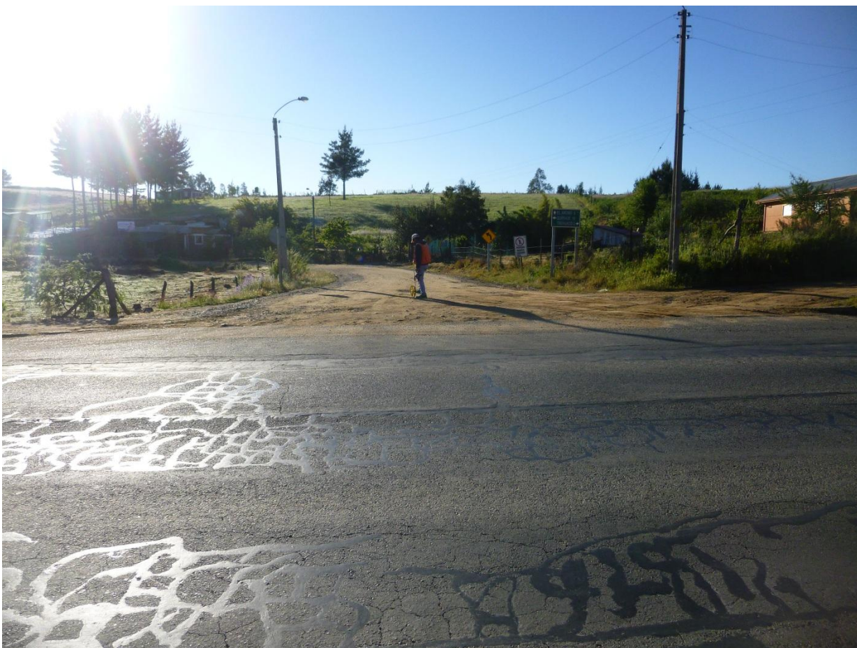
Km 0.280 vista adelante. Ancho de faja 8,50 m, carpeta de 5.00 m al hombro + 0.75 m de cuneta i/d. se aprecia intersección con ruta Trehuaco – Quirihue donde ruta atraviesa para el lado oriente de la ruta N-126. Agua lluvia evacua a hacia ruta N-126
