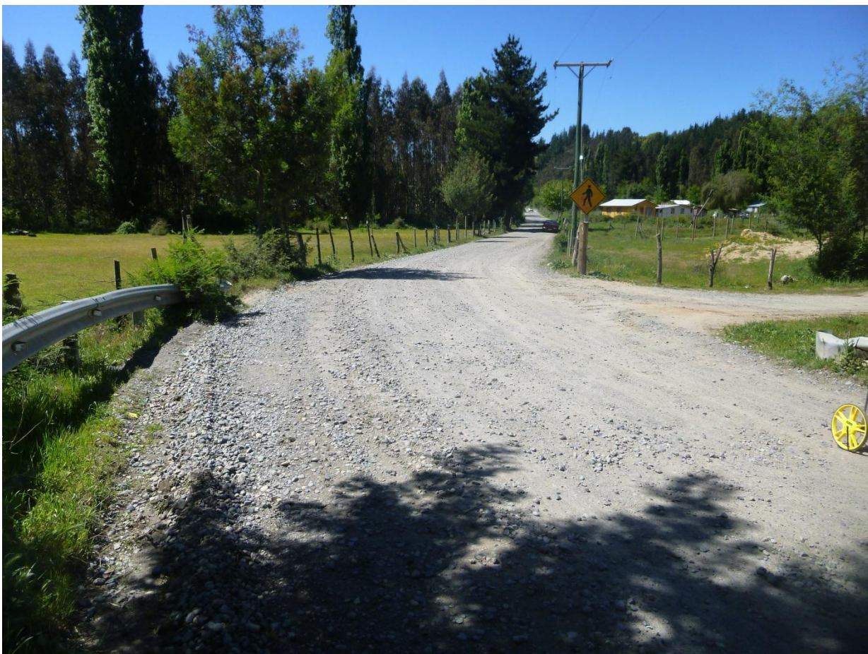
Km 0.00 vista adelante. Ancho de faja de 9.00 m; carpeta de 4.50 m +0.60 m de cuneta i/d. Carpeta con buena presencia de material granular en buen estado. La rasante del camino se encuentra a una misma cota lados i/D. en este punto termina el limite urbano.
