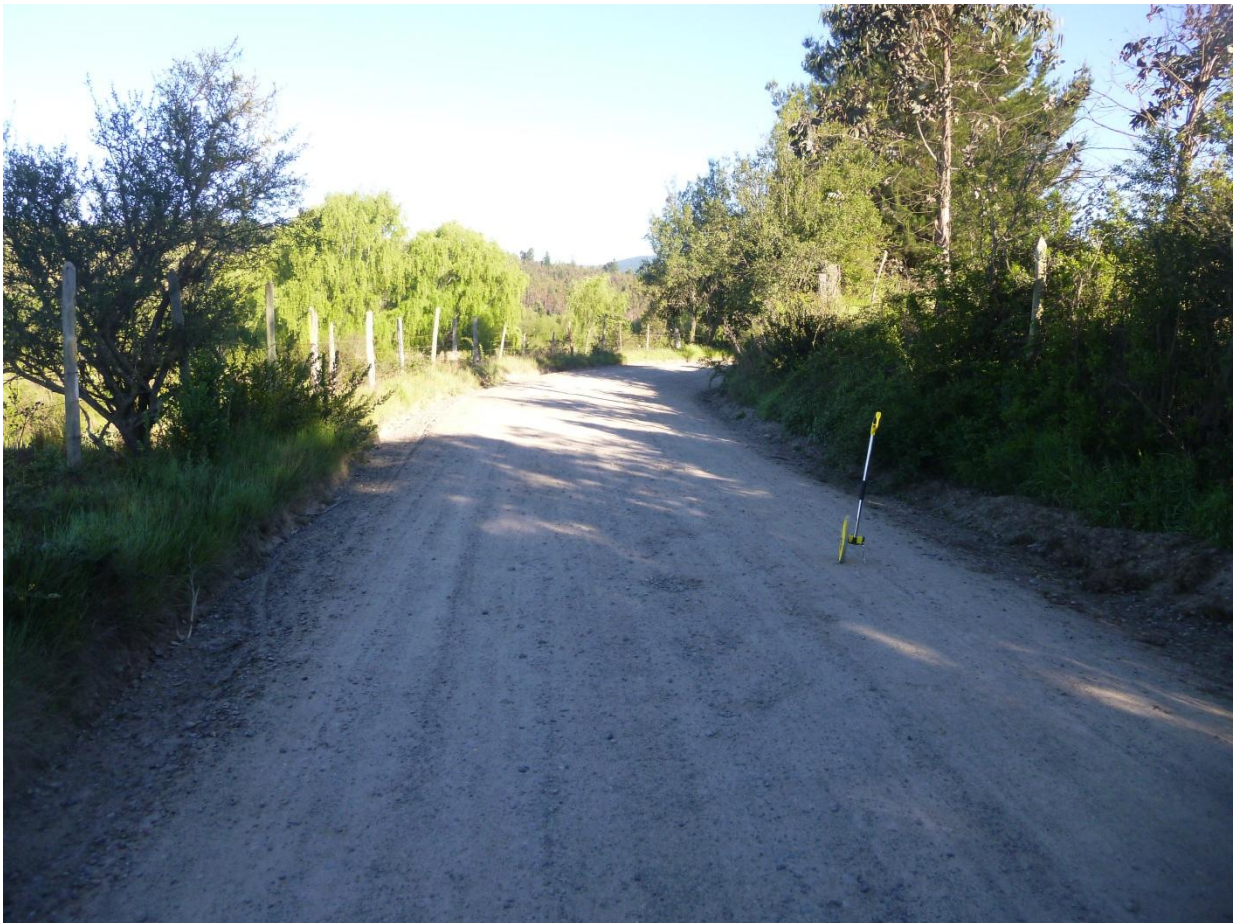
km 0.900 vista adelante. Ancho de faja 9.00 m. carpeta de 4.50 m. al hombro de la carpeta, cuneta lado i/d + 0.40 m. Carpeta con buena presencia de material granular en buen estado. La rasante del camino se encuentra a una cota inferior lados der. y superior lado izq.
