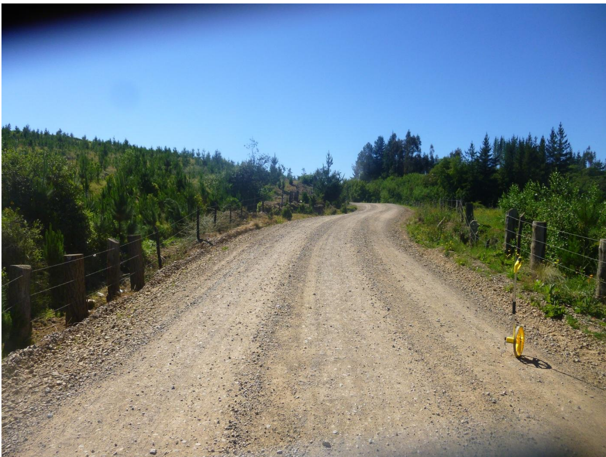
Km 0.500 vista adelante. Ancho de faja 90.00 m. carpeta de 5,00 m. al hombro de la carpeta, cuneta lado i/d + 0.9 m. Carpeta con buena presencia de material granular en buen estado. Agua escurre apunto bajo del km. anterior
