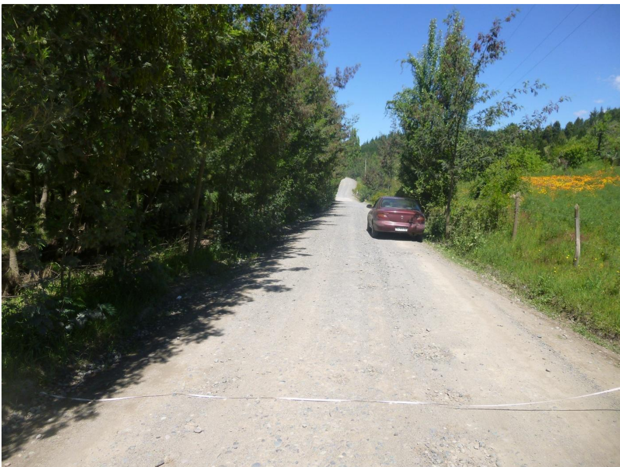
Km 3.84 vista adelante. Ancho de faja 8.00 m. carpeta de 4.00 m. al hombro de la carpeta, cuneta lado i/d + 1.00m. En este punto se encuentra la rasante a un mismo lado izq. e inferior lado der. Zona poblada
