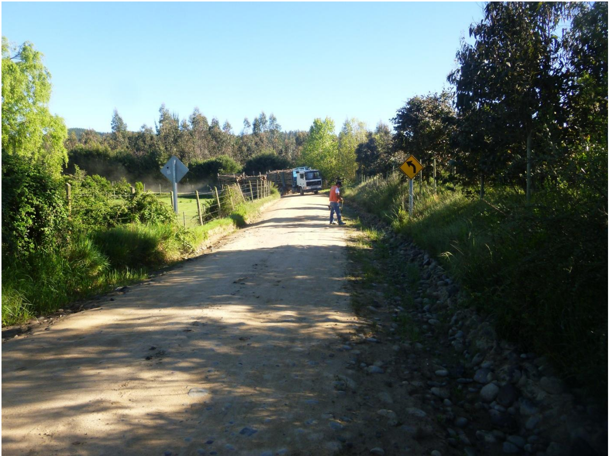
Km 2.60 vista adelante. Ancho de faja 9.00 m. carpeta de 4.50 m. al hombro de la carpeta, cuneta lado izq + 0.4 m. y lado der + 0.8 m. Carpeta con buena presencia de material granular en buen estado la rasante del camino con respecto al nivel de los terreno aledaños está a una cota inferior lado der. y superior lado izq. Zonas de curvas
