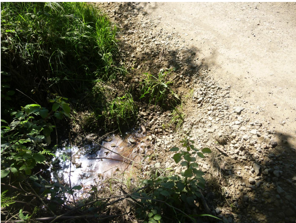
Km 0.330 vista adelante. Ancho de faja de 13.0 m; carpeta de 4.00 m +0.60 m de cuneta i/d. Carpeta con buena presencia de material granular en buen estado. La rasante del camino se encuentra a una cota superior lados izq. e inferior lado der. se aprecia alcantarilla de A.C de diámetro de 400 mm. Largo de 7.00 mts.
