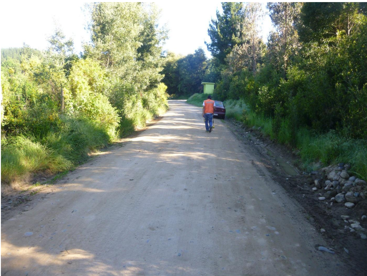
Km 2.90 vista adelante. Ancho de faja 9.00 m. carpeta de 4.00 m. al hombro de la carpeta, cuneta lado izq + 0.4 m. y lado der + 0.8 m. Carpeta con poca presencia de material granular en buen estado la rasante del camino con respecto al nivel de los terrenos está a una cota inferior i/d. Zonas de curvas.
