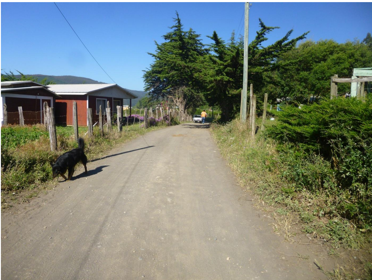
Km 0.100 vista adelante. Ancho de faja de 6.00 m; carpeta de 3.00 m +0.80 m de cuneta i/d. punto alto. Carpeta sin presencia de material granular en buen estado. La rasante del camino se encuentra a una misma cota lados i/d, agua lluvia escurre asía punto bajo anterior. Postes eléctricos en faja
