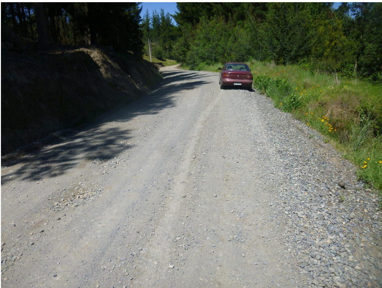
Km 3.91 vista adelante. Ancho de faja 8.50 m. carpeta de 5.00 m. al hombro de la carpeta, cuneta lado i/d + 0.60m. En este punto se encuentra la rasante a un mismo nivel lado i/d. carpeta en buen estado. Existe puente en buen estado de nombre VILLA ALEGRE
