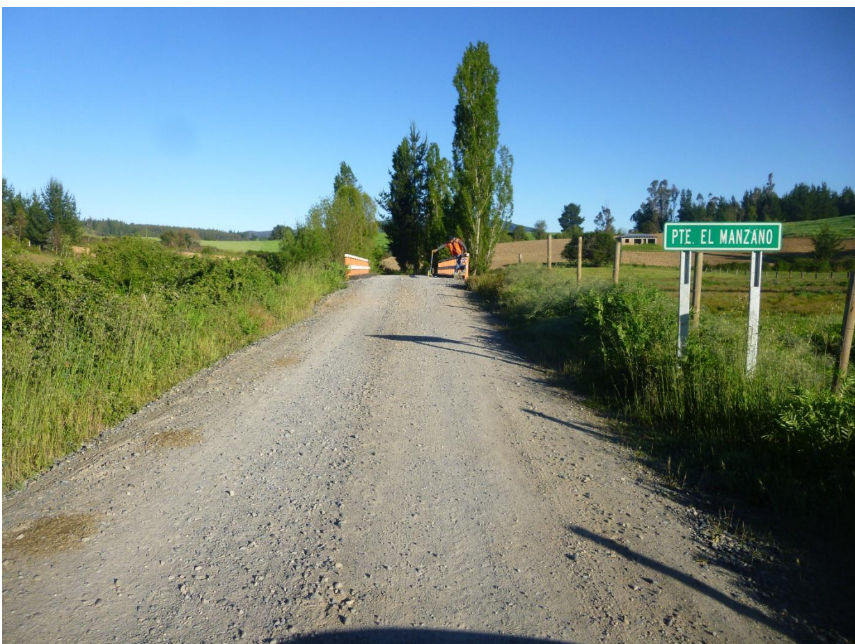
Km 0.300 vista adelante. Ancho de faja de 6.00 m; carpeta de 3.00 m +0.50 m de cuneta i/d. Carpeta con buena presencia de material granular en buen estado. La rasante del camino se encuentra a una cota superior i/d. se aprecia puente de hormigon
