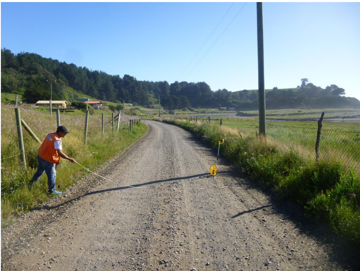
Km 0.200 vista adelante. Ancho de faja de 7.50 m; carpeta de 4.00 m +0.50 m de cuneta i/d.. Carpeta con presencia de material granular en buen estado. La rasante del camino se encuentra a una misma cota lados i/d. Postes eléctricos en faja
