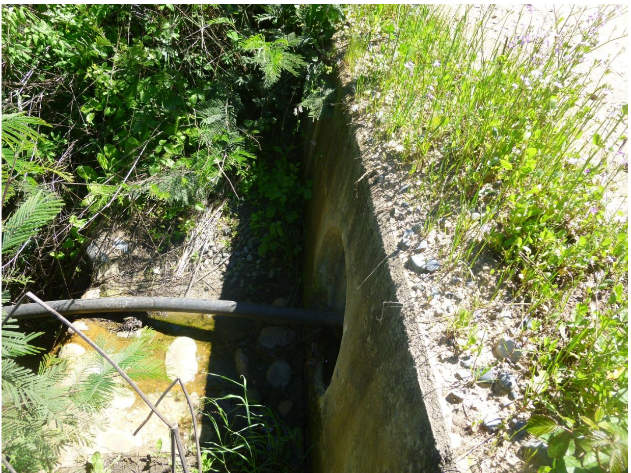
Km 1.20 vista adelante. Ancho de faja 10.00 m. carpeta de 4,50 m. al hombro de la carpeta, cuneta lado izq + 0.4 m. y lado der + 0.3 m. la rasante del camino con respecto al nivel de los terreno aledaños está a una misma cota lado der. y superior lado izq. se aprecia alcantarilla A.C de 700 mm. De un largo de 7.00 mts.
