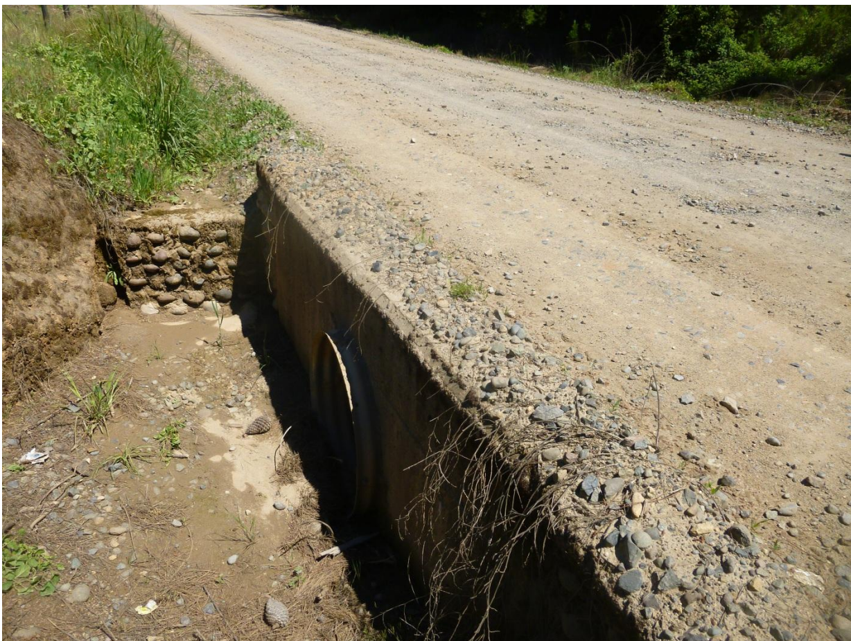
Km 4.30 vista adelante. Ancho de faja 11.00 m. carpeta de 5.00 m. al hombro de la carpeta, cuneta lado i/d + 0.60m. En este punto se encuentra la rasante a un nivel inferior con respecto a terrenos aledaños lado izq. superior lado der. Carpeta en buen estado. Alcantarilla A.C diámetro 800 mm. Largo 7.00 mts. Zonas de curvas. Y postes en faja del camino.
