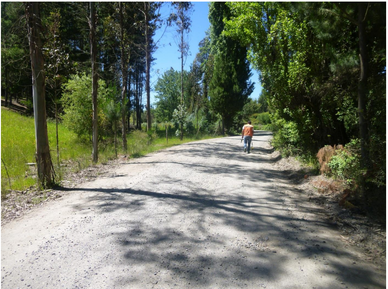
Km 0.600 Km 0.400 vista adelante. Ancho de faja 10.00 m. carpeta de 4.50 m. al hombro de la carpeta, cuneta lado i/d + 0.70 m. Carpeta con buena presencia de material granular en buen estado. Rasante al mismo nivel que terrenos aledaños. Lados i/d.
