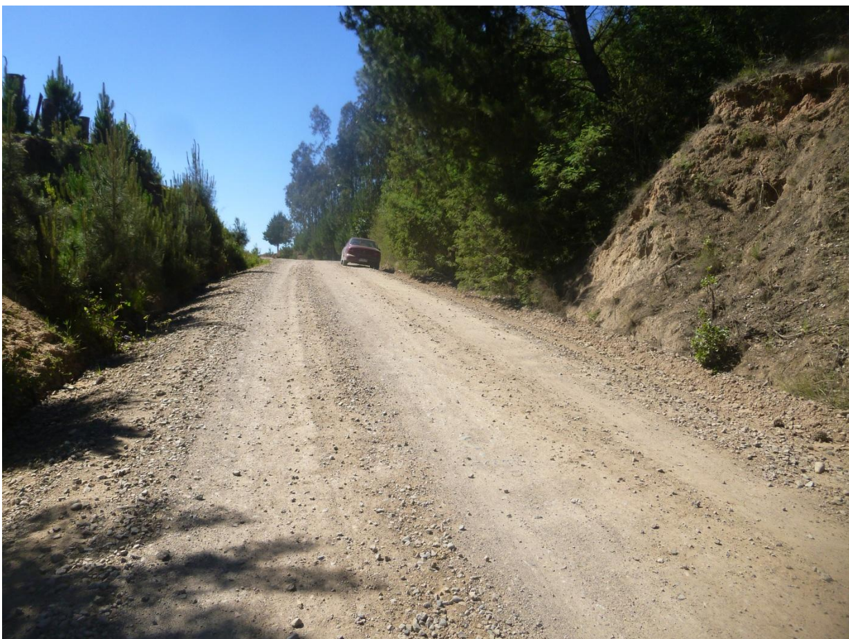
Km 0.700 vista adelante. Ancho de faja 15.00 m. carpeta de 5,00 m. al hombro de la carpeta, cuneta lado i/d + 0.95 m. Carpeta con buena presencia de material granular en buen estado. La rasante del camino se encuentra a una cota inferior lados i/D. punto alto. Agua lluvia escurre a punto bajo anterior.
