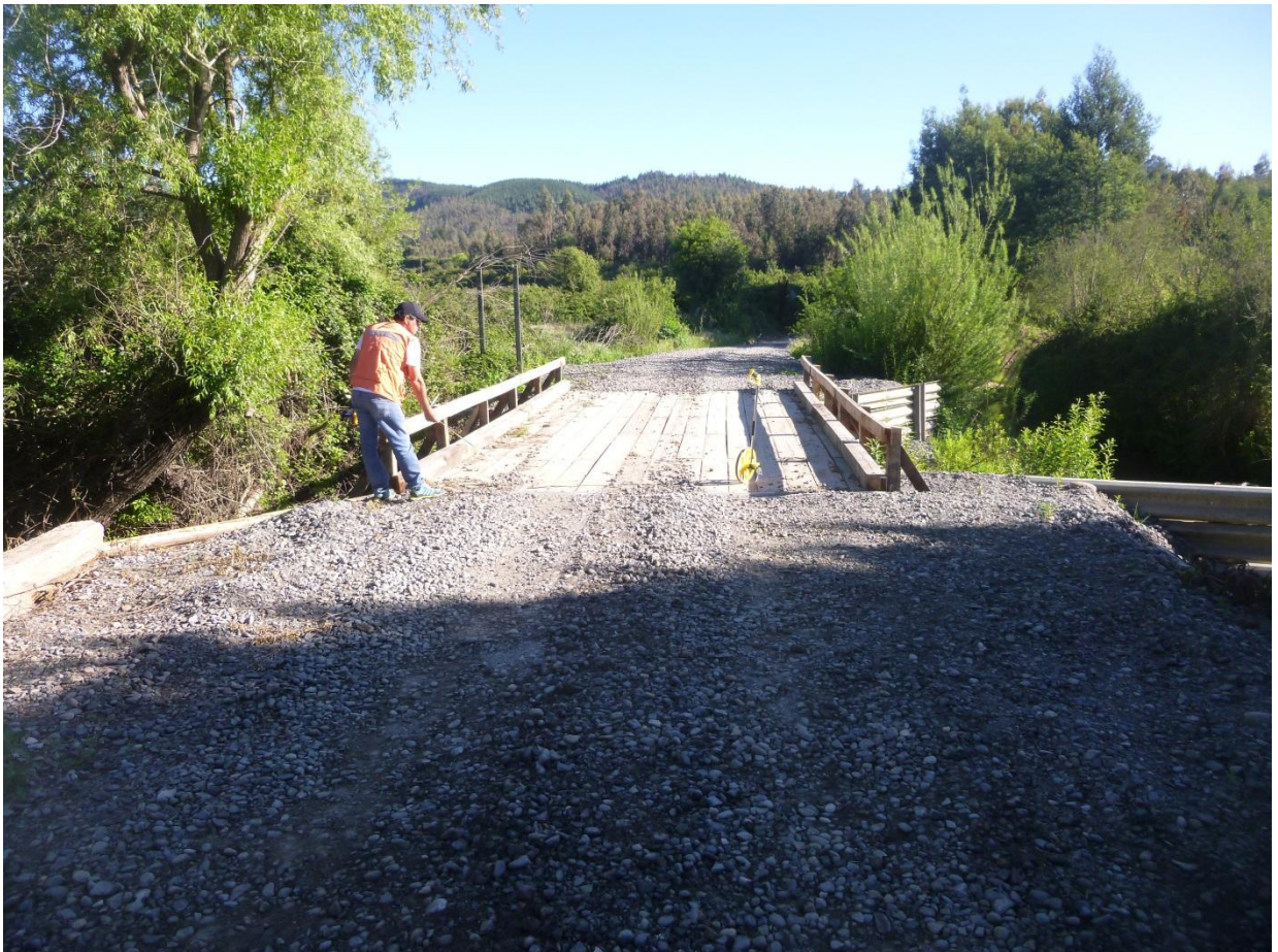
Km 2.20 vista adelante. Ancho de faja 9.00 m. carpeta de 3.50 m. al hombro de la carpeta, cuneta lado izq + 0.7 m. y lado der + 0.8 m. Carpeta con buena presencia de material granular en buen estado la rasante del camino con respecto al nivel de los terreno aledaños está a una misma cota i/d. entrada a puente de madera.
