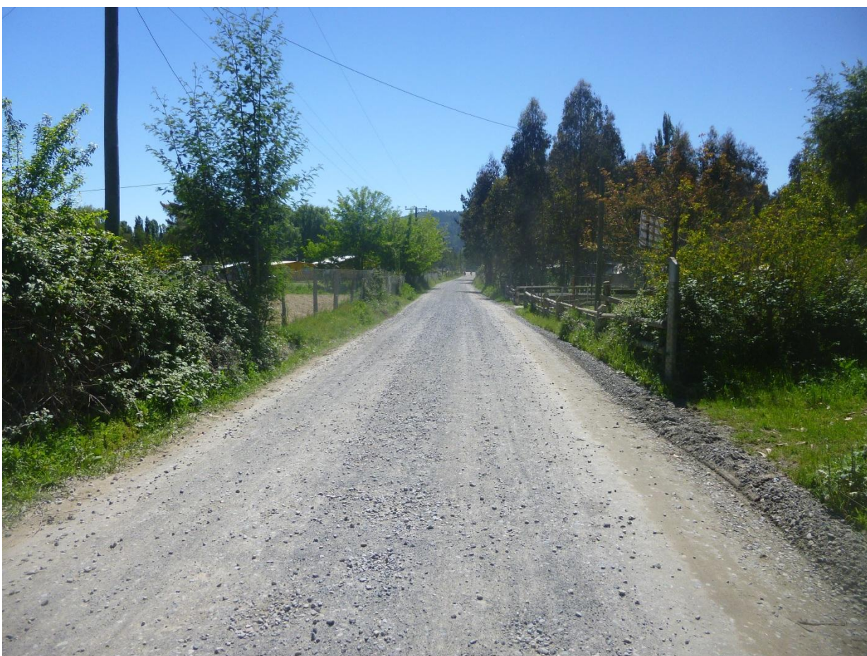
Km 0.200 vista adelante. Ancho de faja de 7.00 m; carpeta de 4.00 m +0.50 m de cuneta i/d. punto alto. Carpeta con buena presencia de material granular en buen estado. Zona con alta densidad de población. Tramo recto
