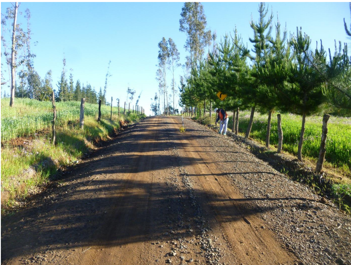
Km 1.100 vista adelante. Ancho de faja 7.00 m. carpeta de 4.00 m. al hombro de la carpeta, cuneta lado i/d + 1.00m. la rasante del camino se encuentra a una cota inferior ambos lados. Agua lluvia escurre a punto bajo del km. anterior
