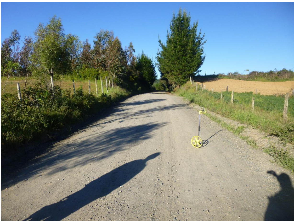
Km 0.530 vista adelante. Ancho de faja 9.00 m. carpeta de 5,00 m. al hombro de la carpeta, cuneta lado i/d + 0.50 m. Carpeta con buena presencia de material granular en buen estado. La rasante del camino se encuentra a una cota superior lados i/D. punto alto. Agua lluvia escurre a punto bajo anterior.
