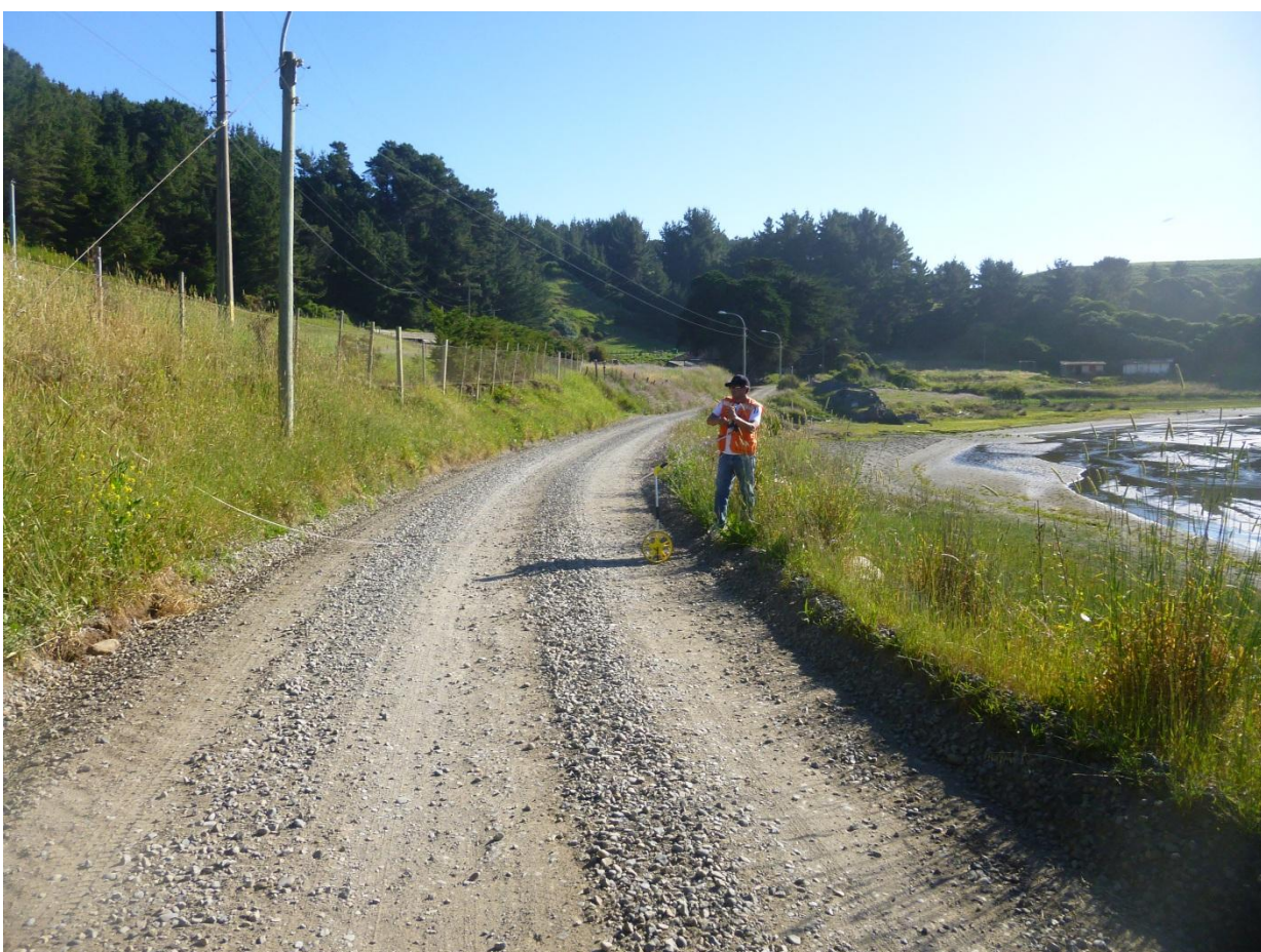
Km 0.400 vista adelante. Ancho de faja de 7.50 m; carpeta de 4.00 m +0.50 m de cuneta i/d.. Carpeta con presencia de material granular en buen estado. La rasante del camino se encuentra a una cota inferior lados izq. y superior lado der.. Postes eléctricos en faja
