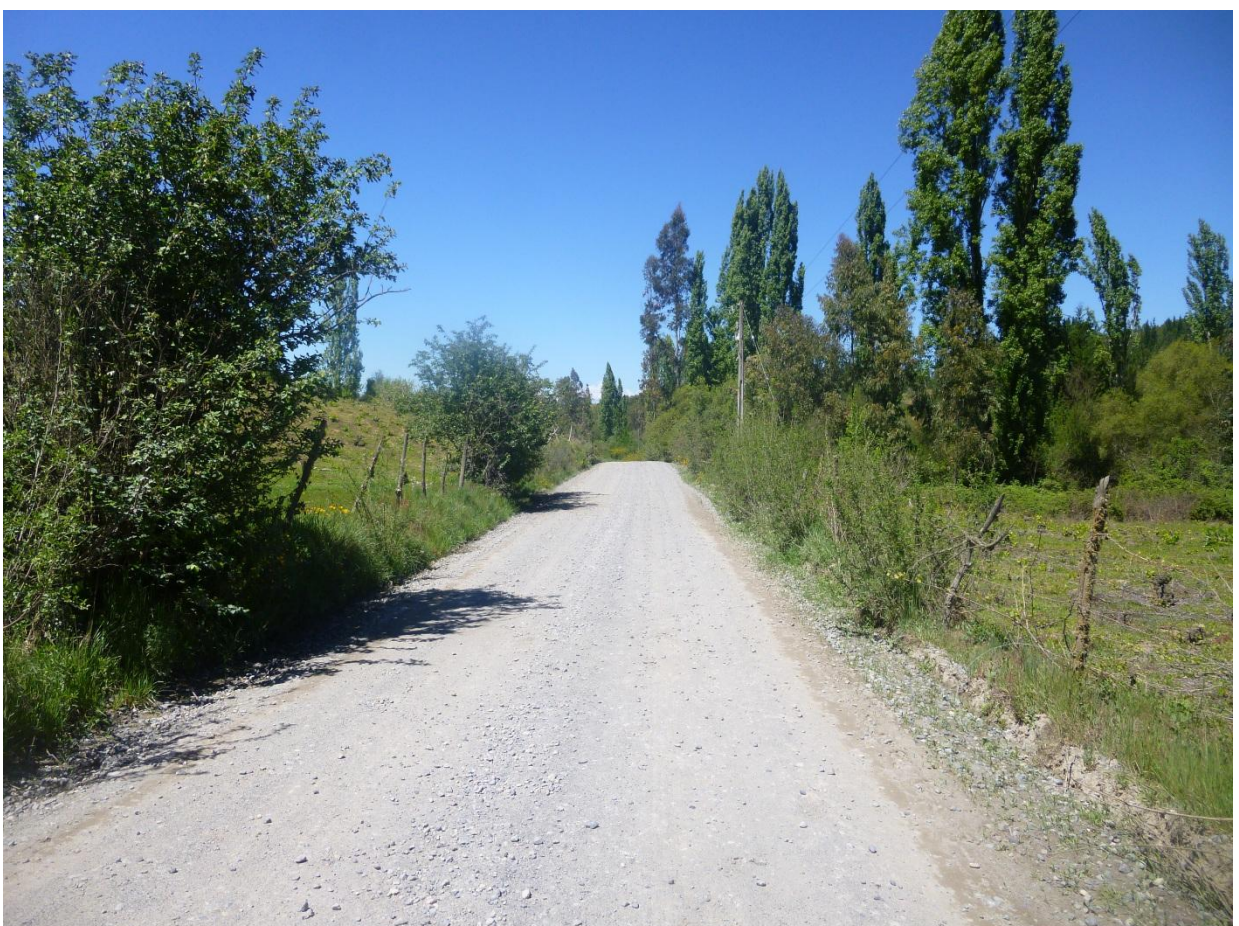
Km 2.40 vista adelante. Ancho de faja 7.00 m. carpeta de 4.50 m. al hombro de la carpeta, cuneta lado i/d + 0.75m. En este punto se encuentra la rasante a un mismo nivel con respecto a los terrenos aledaños lado i/d. Tramo recto
