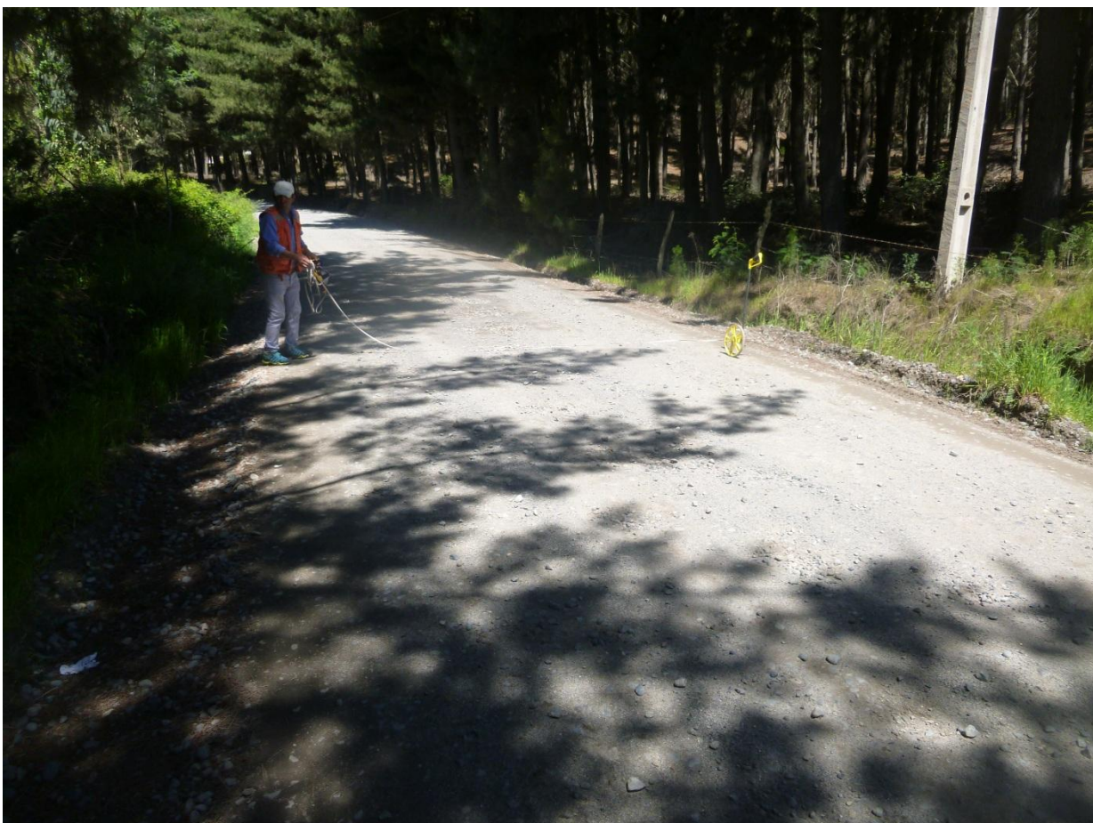
Km 3.30 vista adelante. Ancho de faja 8.50 m. carpeta de 4.50 m. al hombro de la carpeta, cuneta lado i/d + 0.70m. En este punto se encuentra la rasante a un mismo nivel lado i/d. Postes eléctricos en faja del camino. Carpeta en buen estado, zona poblada. Alcantarilla de A.C de diámetro 800 mm. Largo de 9.00 mts.
