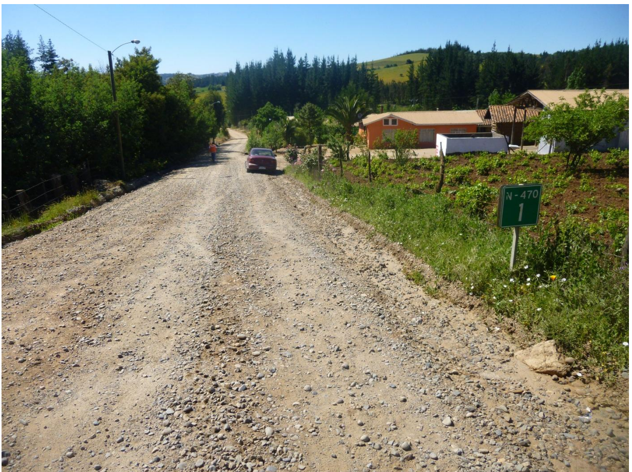
km 1.00 vista adelante. Ancho de faja 11.00 m. carpeta de 5,50 m. al hombro de la carpeta, cuneta lado i/d + 0.75 m. Carpeta con buena presencia de material granular en buen estado. La rasante del camino se encuentra a una cota inferior lados der. e inferior lado izq. punto alto, postes eléctricos en faja del camino.
