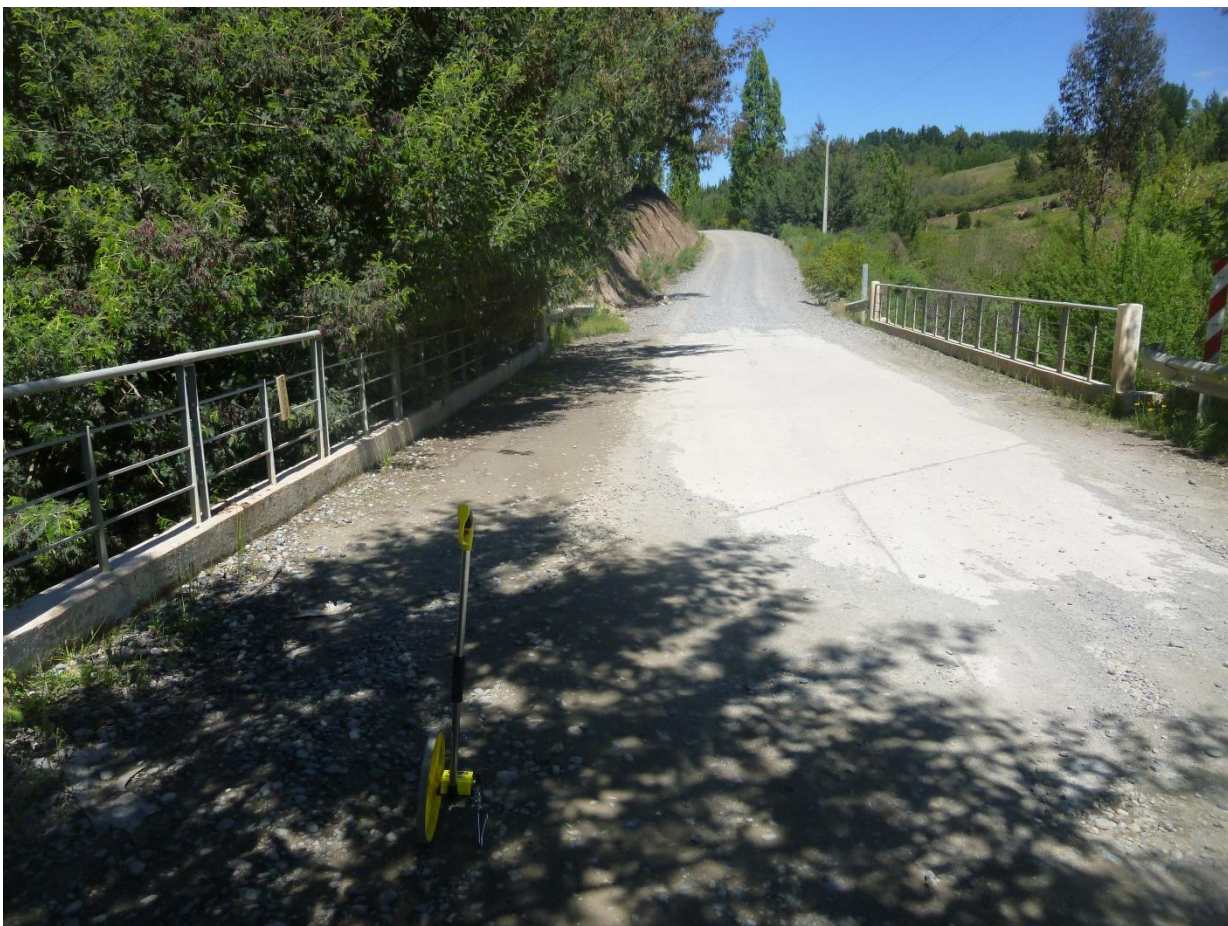
Km 3.91 vista adelante. Ancho de faja 8.50 m. carpeta de 5.00 m. al hombro de la carpeta, cuneta lado i/d + 0.60m. En este punto se encuentra la rasante a un mismo nivel lado i/d. carpeta en buen estado. Existe puente en buen estado de nombre VILLA ALEGRE
