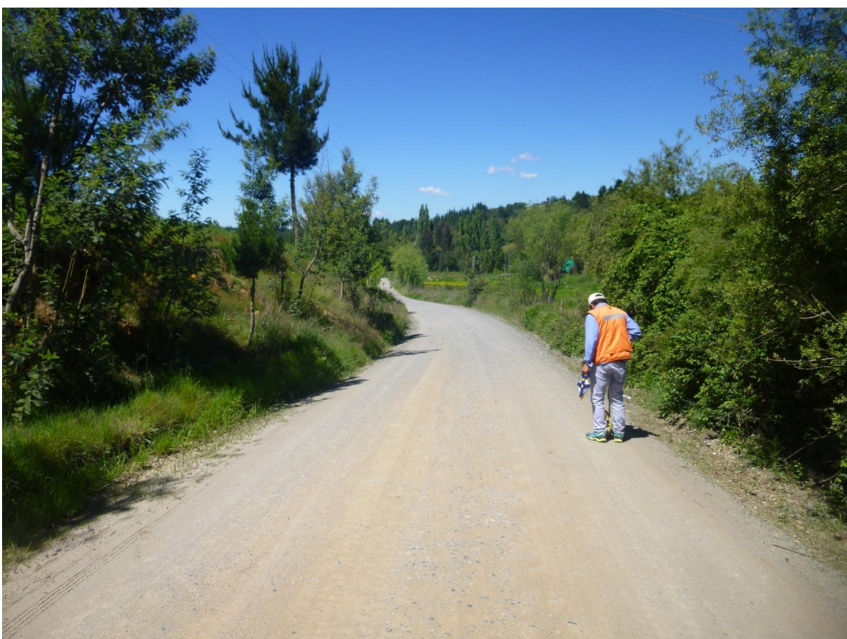
Km 2.00 vista adelante. Ancho de faja 8.00 m. carpeta de 4.50 m. al hombro de la carpeta, cuneta lado i/d + 0.75m. En este punto se encuentra la rasante del camino a un nivel inferior con respecto a los terrenos aledaños lado izq. y superior lado der. Zona poblada.
