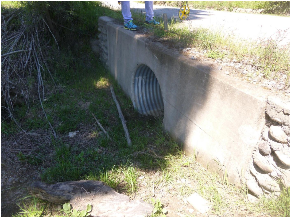
Km 3.10 vista adelante. Ancho de faja 7.00 m. carpeta de 4.50 m. al hombro de la carpeta, cuneta lado i/d + 0.50m. En este punto se encuentra la rasante a un mismo nivel lado i/d. alcantarilla de A.C de diámetro 800 mm. Largo de 7.00 mts.
