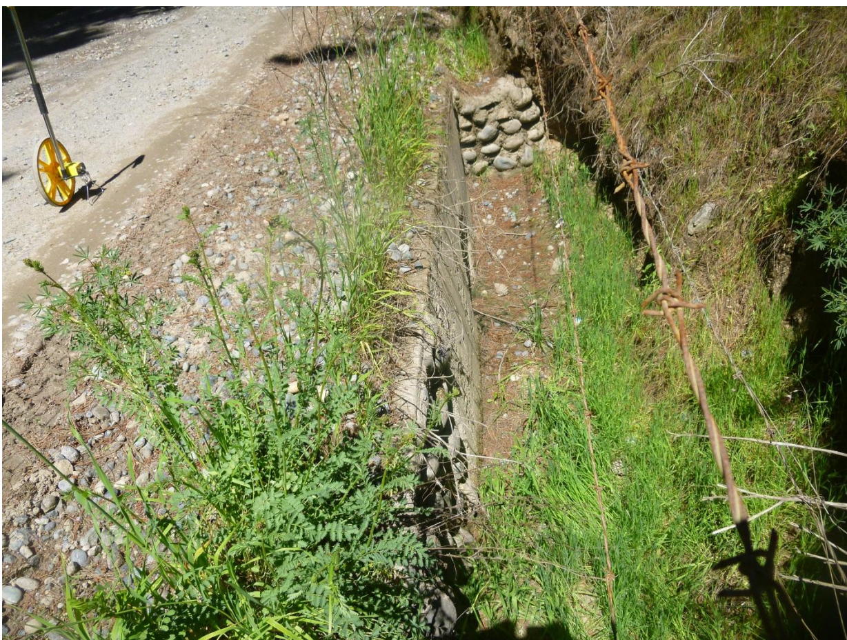
Km 3.44 vista adelante. Ancho de faja 10.00 m. carpeta de 5.00 m. al hombro de la carpeta, cuneta lado i/d + 0.70m. En este punto se encuentra la rasante a un mismo nivel lado i/d.. Carpeta en buen estado. Alcantarilla de A.C de diámetro 800 mm. Largo de 9.00 mts.
