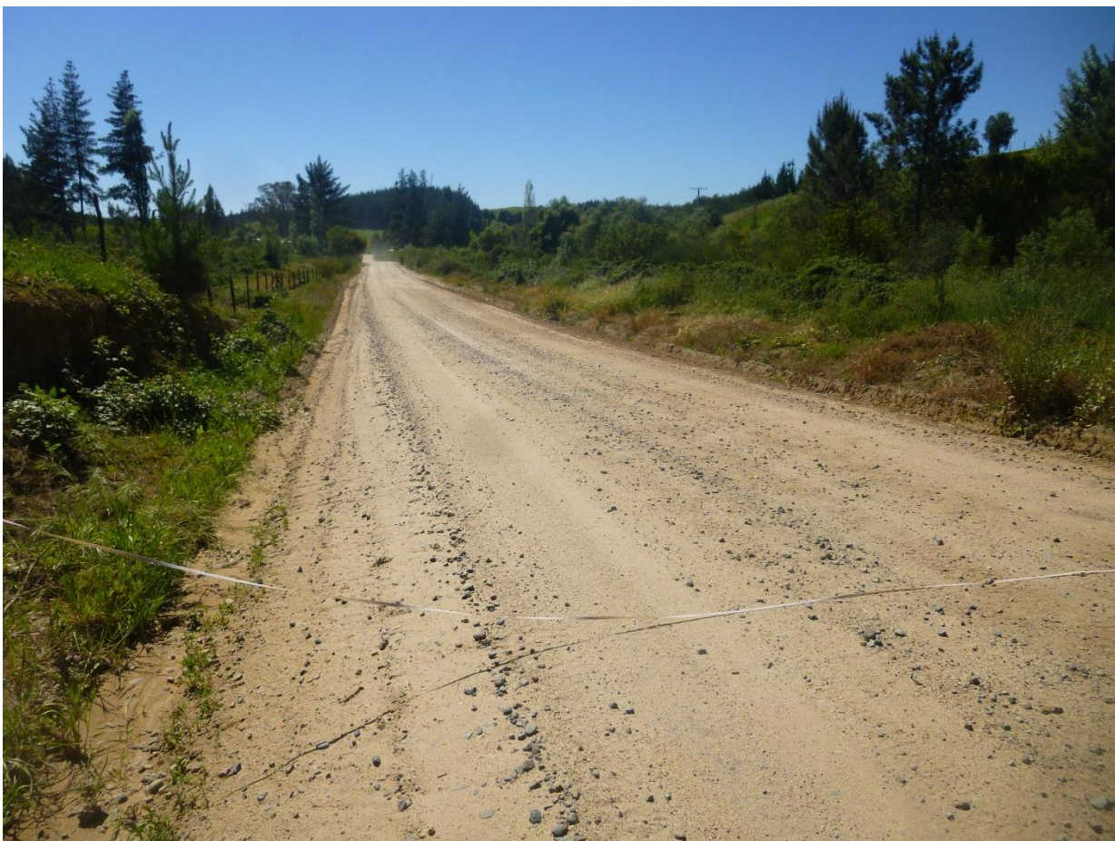
Km 1.400 vista adelante. Ancho de faja 12.00 m. carpeta de 5,00 m. al hombro de la carpeta, cuneta lado i/d + 1.00 m. Carpeta con buena presencia de material granular en buen estado. La rasante del camino se encuentra a una cota inferior lados i/D.
