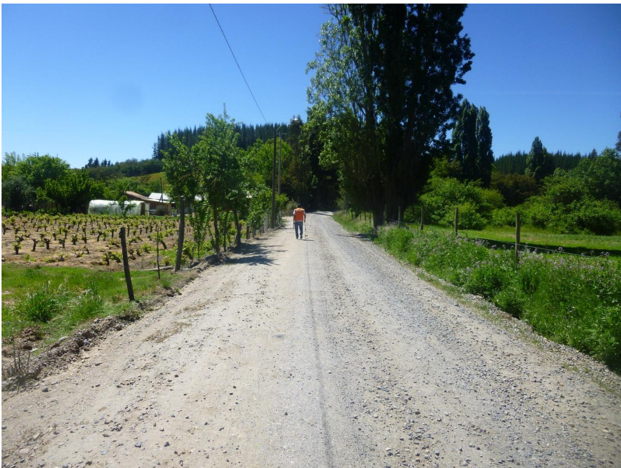
Km 0.200 vista adelante. Ancho de faja de 8.00 m; carpeta de 4.00 m +0.70 m de cuneta i/d. Carpeta con buena presencia de material granular en buen estado. La rasante del camino se encuentra a una misma cota i/d.
