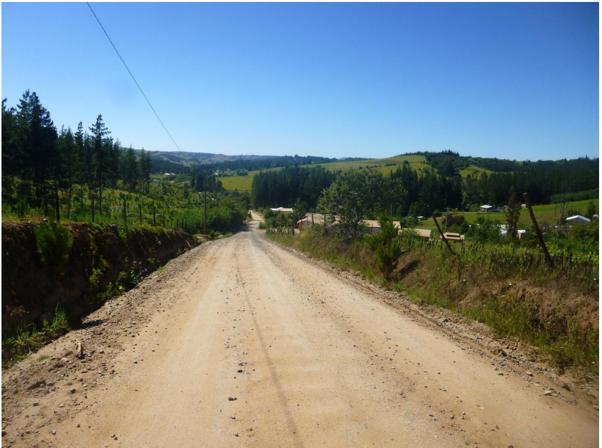
Km 0.900 vista adelante. Ancho de faja 11.00 m. carpeta de 5,00 m. al hombro de la carpeta, cuneta lado i/d + 0.75 m. Carpeta con buena presencia de material granular en buen estado. La rasante del camino se encuentra a una cota inferior lados i/D. punto alto, postes electricos en faja del camino.
