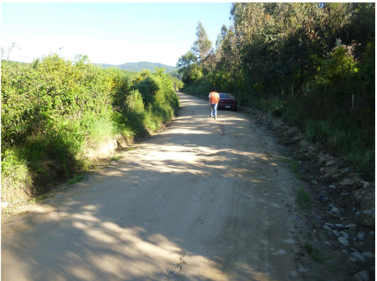
Km 2.40 vista adelante. Ancho de faja 8.00 m. carpeta de 3.50 m. al hombro de la carpeta, cuneta lado izq + 0.5 m. y lado der + 0.7 m. Carpeta con poca presencia de material granular en buen estado la rasante del camino con respecto al nivel de los terreno aledaños está a una cota inferior i/d. punto alto agua escurre a punto bajo del km. anterior. Zonas de curvas.
