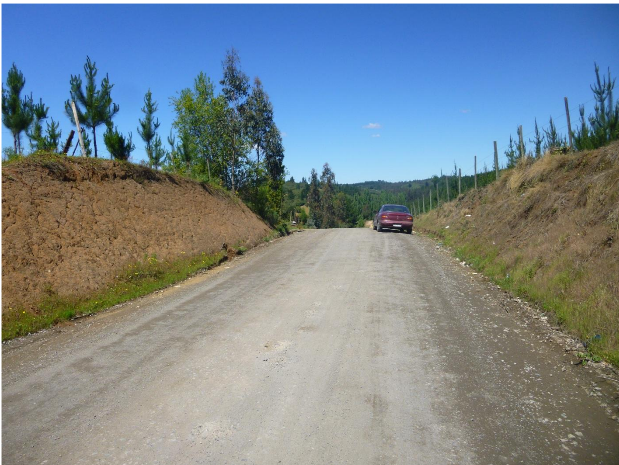
Km 1.800 DEL ACUMULADO vista adelante. Ancho de faja 16.00 m. carpeta de 5,00 m. al hombro de la carpeta, cuneta lado izq + 0.8 m. y lado der + 0.9 m. En este punto se encuentra la rasante a un nivel inferior con respecto a los terrenos aledaños lado i/d. punto alto donde finaliza la subida de la cuesta, carpeta en general en buen estado.
