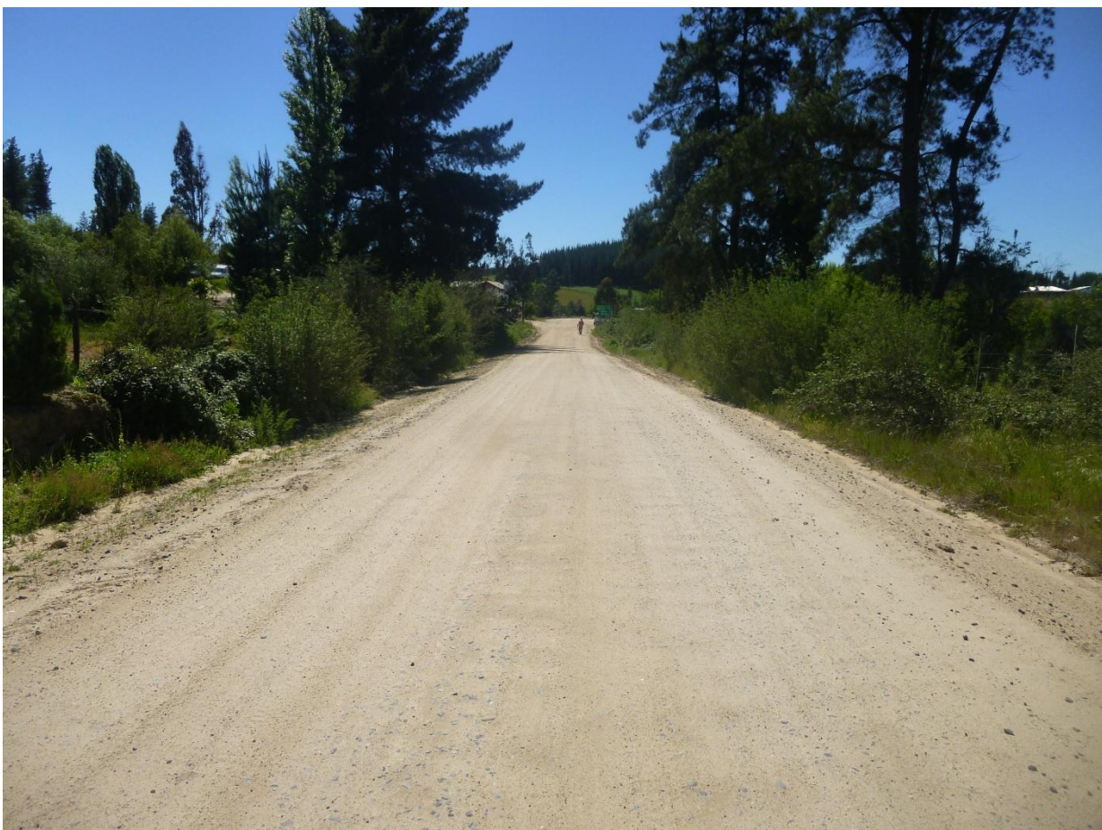
Km 1.600 vista adelante. Ancho de faja 13.00 m. carpeta de 5,00 m. al hombro de la carpeta, cuneta lado izq + 1.00 m. y lado der + 0.9 m. la rasante del camino con respecto al nivel de los terreno aledaños está a una misma cota lado der. Y superior lado izq. se aprecia alcantarilla A.C de 700 mm. De un largo de 7.00 mts.
