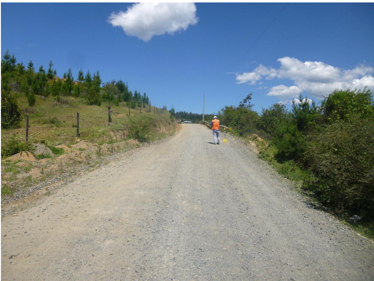
Km 4.50 vista adelante. Ancho de faja 11.00 m. carpeta de 4.50 m. al hombro de la carpeta, cuneta lado i/d + 0.80m. En este punto se encuentra la rasante a un nivel inferior con respecto al promedio en general del camino lado izq. superior lado der, carpeta en buen estado. Postes en faja del camino.
