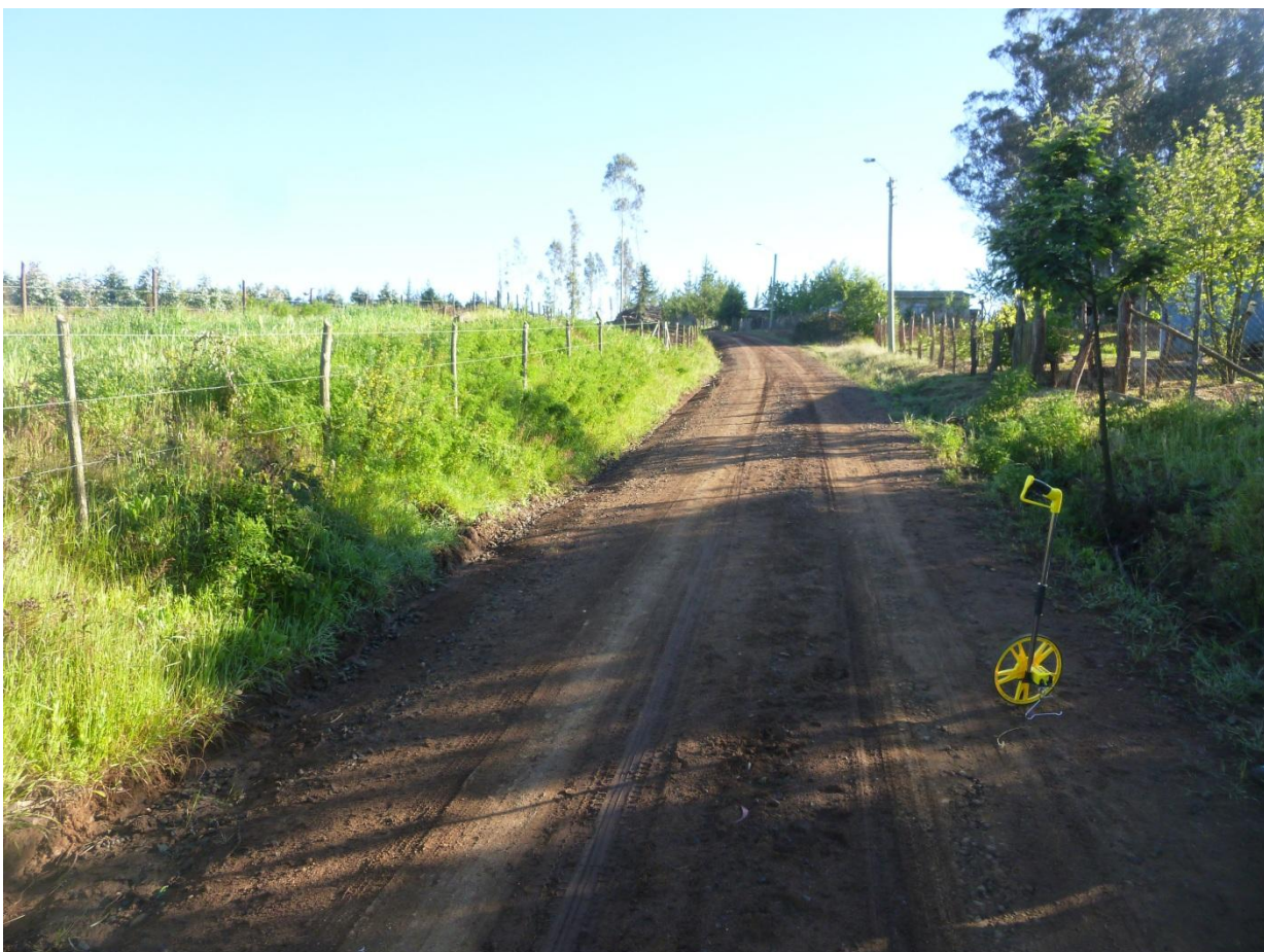
Km 0.900 vista adelante. Ancho de faja 8.00 m. carpeta de 3,50 m. al hombro de la carpeta, cuneta lado izq + 0.8 m. y lado der + 0.7 m. la rasante del camino con respecto al nivel de los terreno aledaños está a una cota inferior. El agua lluvia escurre por las cunetas hacia el punto bajo que se encuentra en km anterior. Postes eléctrico en faja del camino.
