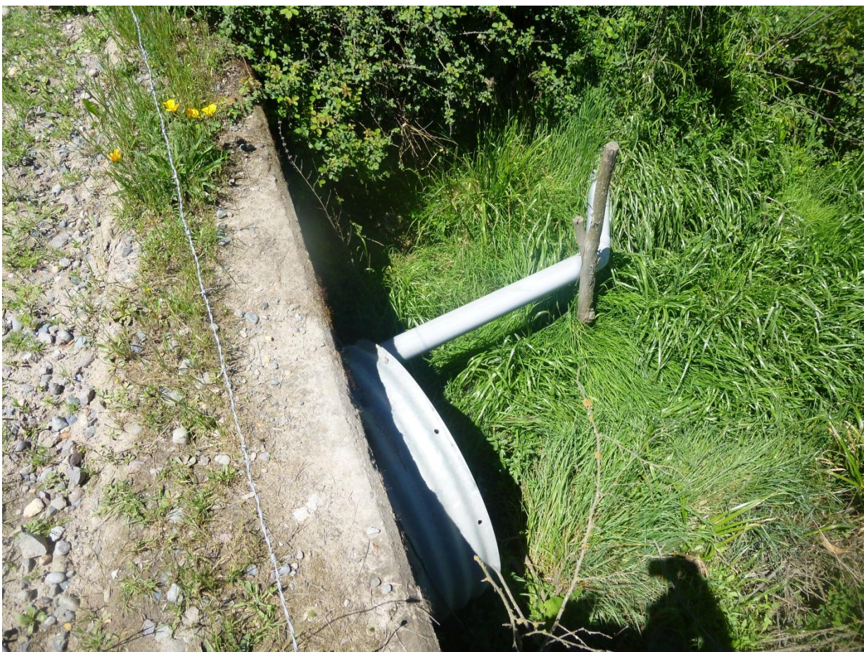
Km 3.00 vista adelante. Ancho de faja 7.00 m. carpeta de 4.50 m. al hombro de la carpeta, cuneta lado i/d + 0.80m. En este punto se encuentra la rasante a un mismo nivel con respecto a los terrenos aledaños lado i/d. Alcantarilla A.C de diámetro 800 mm. Largo de 7.00 mts. Tramo recto
