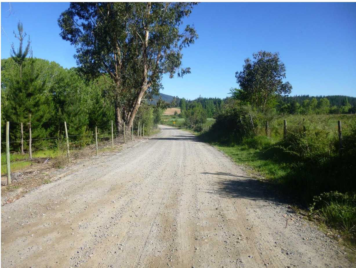
Km 0.100 vista adelante. Ancho de faja de 10.00 m; carpeta de 5.50 m +0.70 m de cuneta i/d. Carpeta con buena presencia de material granular en buen estado. La rasante del camino se encuentra a una cota superior lados izq. e inferior lado der
