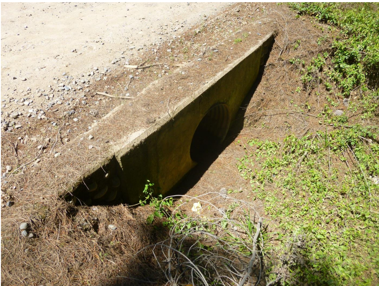
Km 4.16 vista adelante. Ancho de faja 11.00 m. carpeta de 4.50 m. al hombro de la carpeta, cuneta lado i/d + 0.70m. En este punto se encuentra la rasante a un nivel inferior con respecto a terrenos aledaños lado izq. superior lado der. Carpeta en buen estado. Alcantarilla A.C diámetro 800 mm. Largo 7.00 mts. Zonas de curvas.
